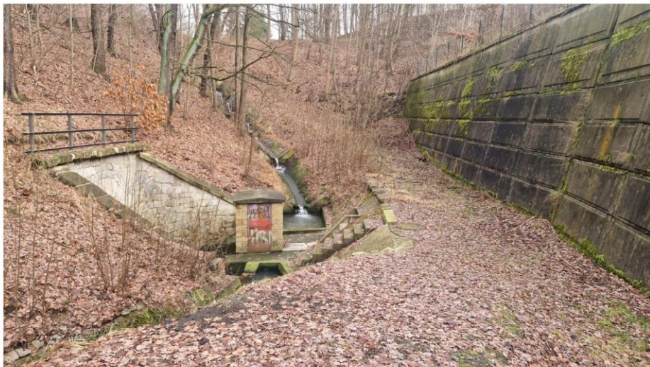
Foto: Pohled na prostor pod čelem skládky TKO Zlaté návrší.
