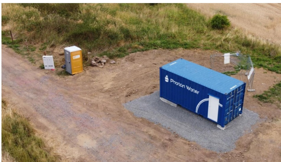
Ilustrační foto: Kontejnerová úprava pitné vody (Pičín – realizace 2023).
