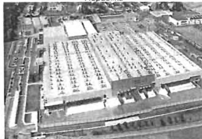
Projektové řízení, technický dozor, kontrola nákladů a BOZP novostavby a rozšíření výrobního závodu LEGO, Kladno, Česká Republika
