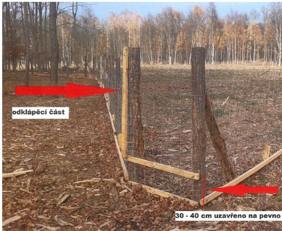
Konec pletiva bude přibitý na lati (kuláček, půlkuláček), jež poslouží k otevírání branky. Odklápací část bude zajištěna proti samovolnému otevření pomocí dvou zahnutých hřebíků umístěných ve spodní a horní části nosného kůlu. Spodní část branky 30-40 cm od země uzavřena na pevno – 2x latě (ráhno).
