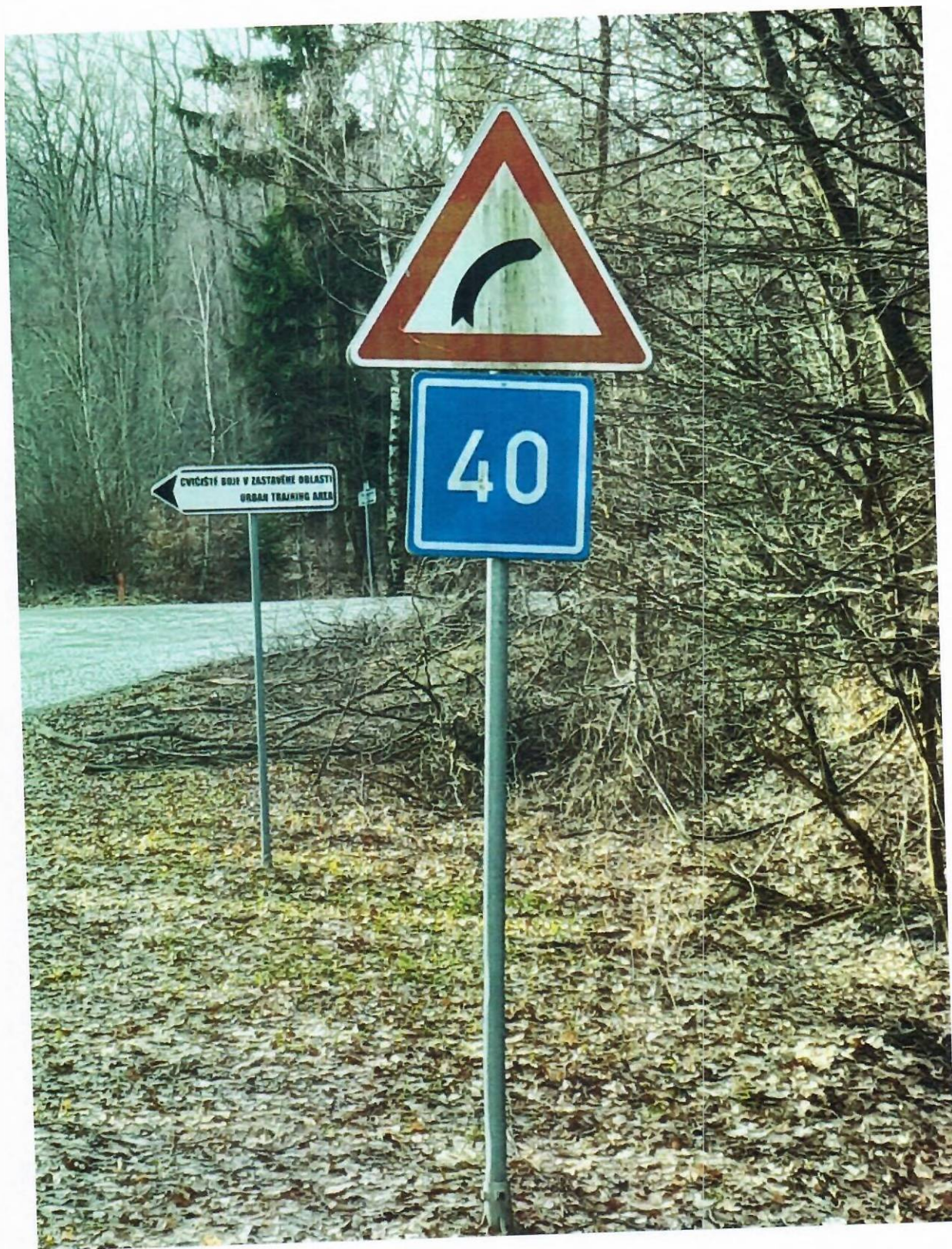
13. Před odbočkou na BTA ve směru Zámeček – Vyškov DZ A 1a – znečištěna - vyčistit
