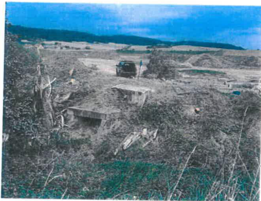
Stav po odstranění dřevin
