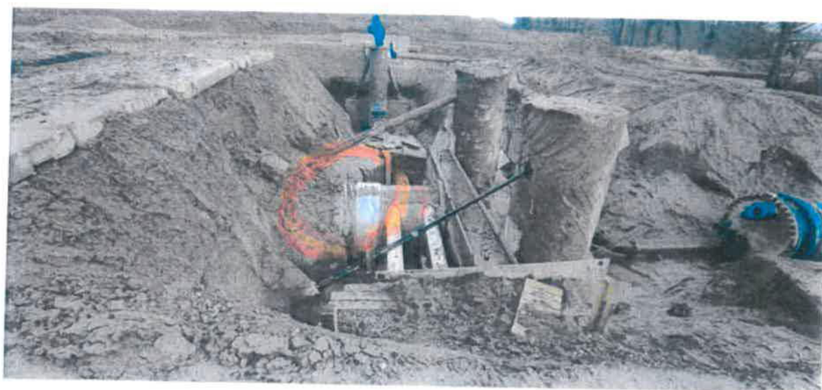
Stávající koleno HOBAS bude vybouráno včetně betonového zajišťovacího bloku (v rozsahu nutném pro položení kolene nového) a nahrazeno kolenem z litiny se zámkovými spoji
