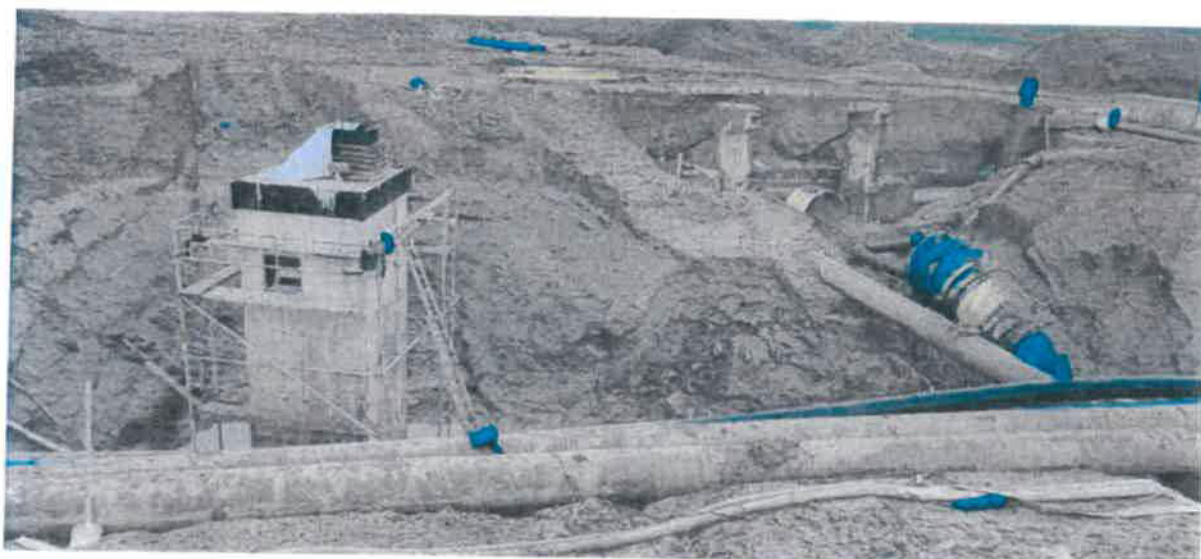
demolici ve fázi výstavby kalníkové šachty
