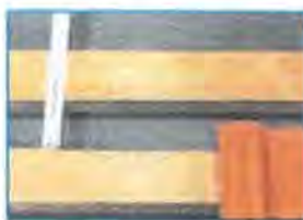
Obr. 1 - Poloha mezilatě pro montáž držáků
