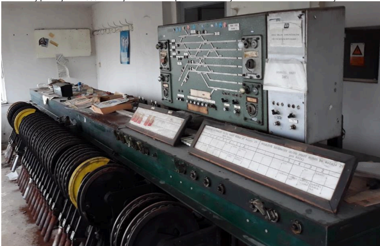
Stavědlový přístroj vzoru 5007 s kolejovou deskou a příslušenstvím bývalého St. 2 ŽST Praha Masarykovo nádraží
