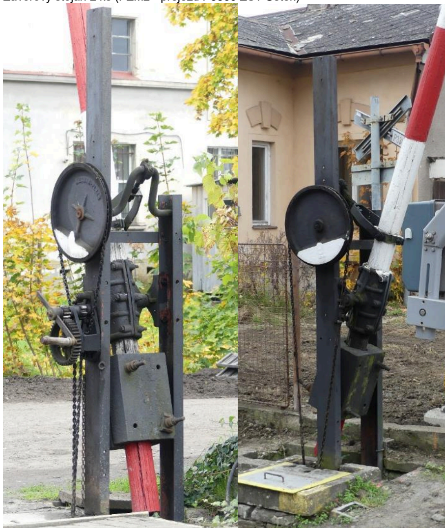
Závorový stojan 2 ks (PZM2 - přejezd P3360 ŽST Ústěk)
