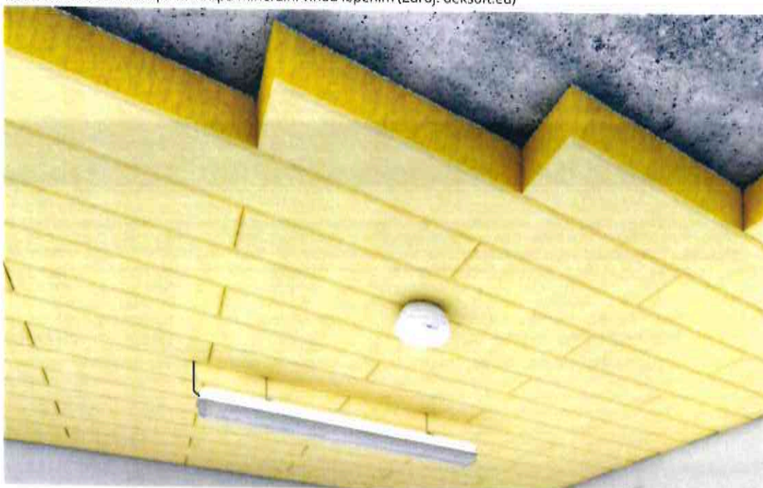
Obrázek č. 3.3.2.2: Zateplení stropu minerální vlnou lepením (Zdroj: deksoft.eu)
