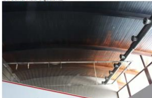
-poškození zuhelnatěním
