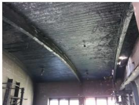
-poškození zuhelnatěním
