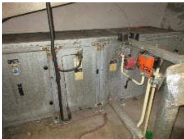
Obrázek 44 stávající VZT zn. Janka pro kuchyň bez ZZT
