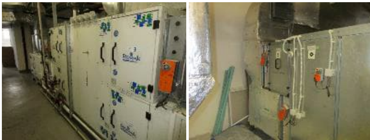
Obrázek 32 VZT zařízení v obj. I s (ZZT) a B – kuchyně bez ZZT
