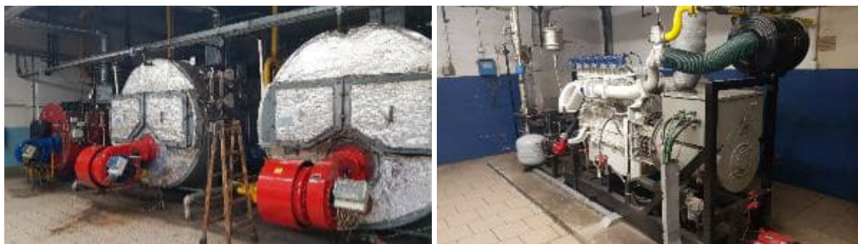
Obrázek 24 Centrální plynová kotelná a KGJ
