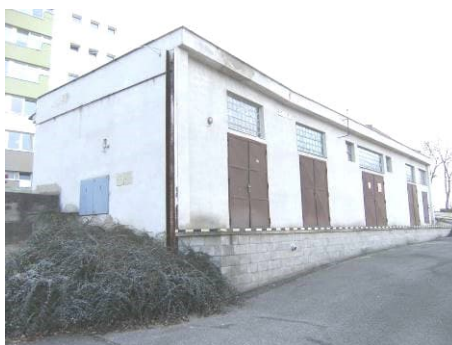
Obrázek č. 8. - pohled na budovu náhradního zdroje
