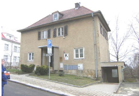
Obrázek č. 12.- pohled na budovu výpočetního střediska
