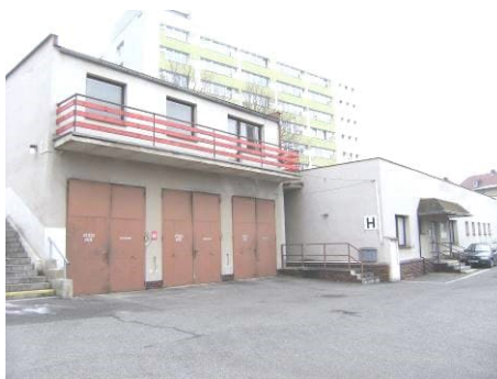
Obrázek č. 7. - pohled na budovu patologie
