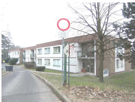
Obrázek č. 16.- pohled na budovu hemodialýzy
