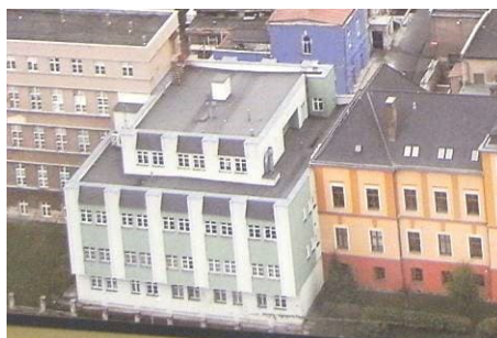
Obrázek č. 3. - pohled na budovu chirurgie a oddělení ARO
