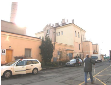
Obrázek č. 1. - pohled na budovu stravovacího provozu z areálu nemocnice
