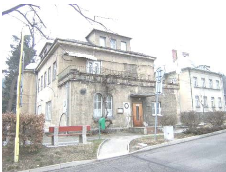
Obrázek č. 15.- pohled na budovu ambulance
