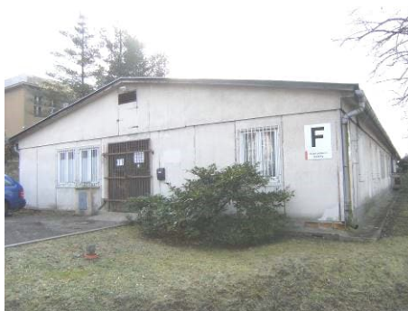
Obrázek č. 5. - pohled na budovu skladu MTZ a knihovny
