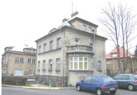
Obrázek č. 14.- pohled na budovu správy a údržby
