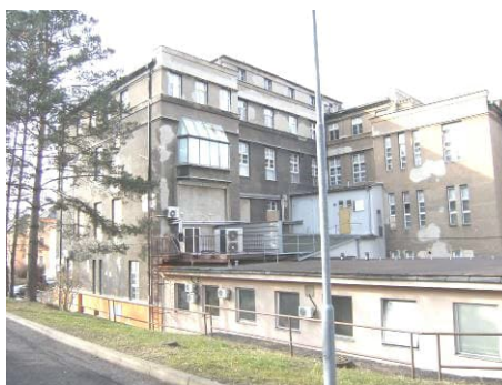
Obrázek č. 4. - pohled na budovu chirurgie
