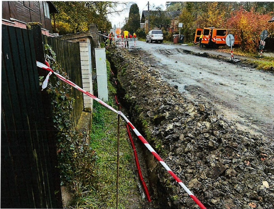
Výkop pro veřejné osvětlení
