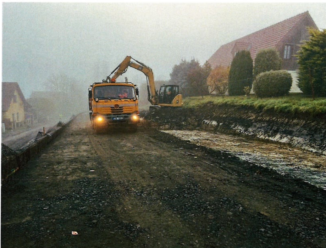
Zazubení stávajícího tělesa
