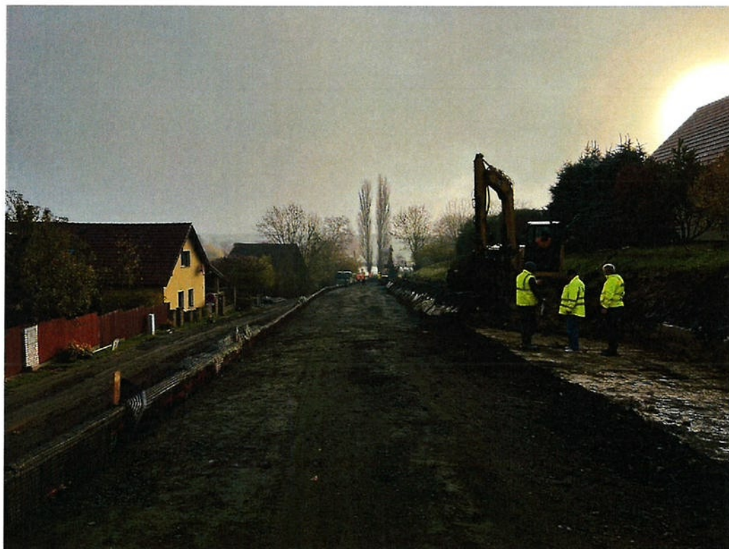
Zazubení stávajícího tělesa
