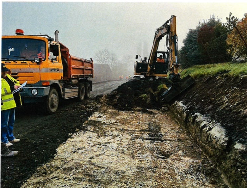
Zazubení stávajícího tělesa
