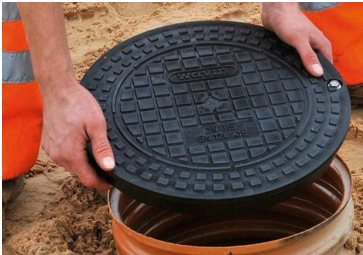
Obrázek 42 Příklad řešení plastové šachty kulaté
