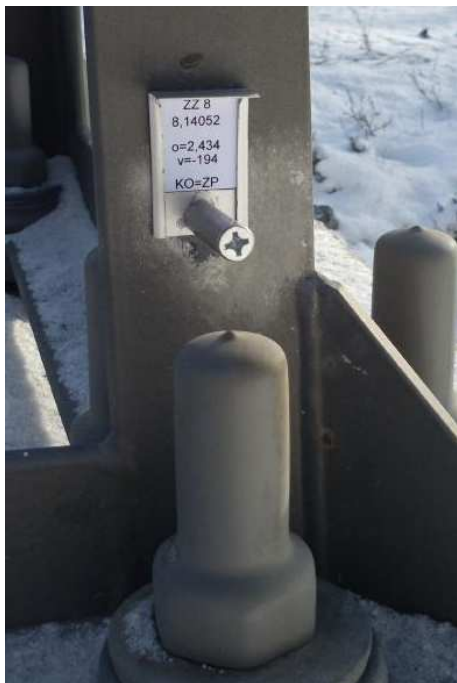
Obrázek 9 Konzolová značka na podpěře trakčního vedení
