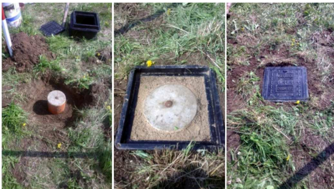
Obrázek 41 Příklad řešení plastové šachty hranaté
