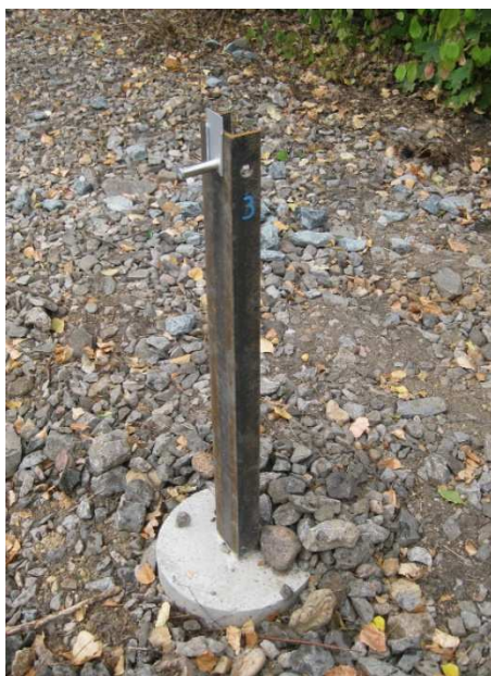
Obrázek 20 Otevřený profil konstrukce sloupku ŽPSV
