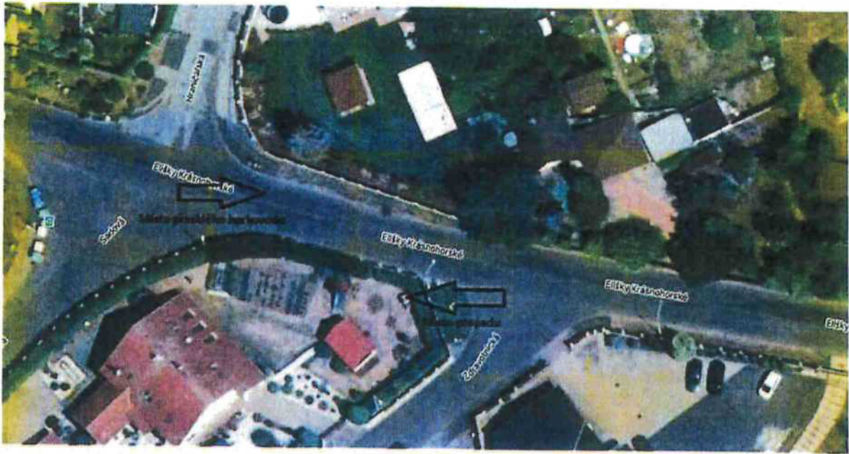
Vyznačení místa prasklého horkovodního potrubí a místa propadu
