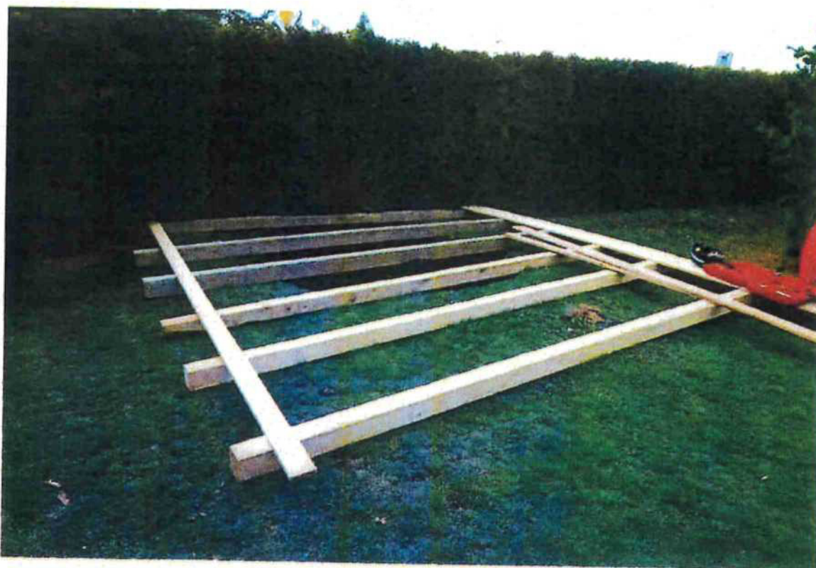
Stavba ochranného povalu
