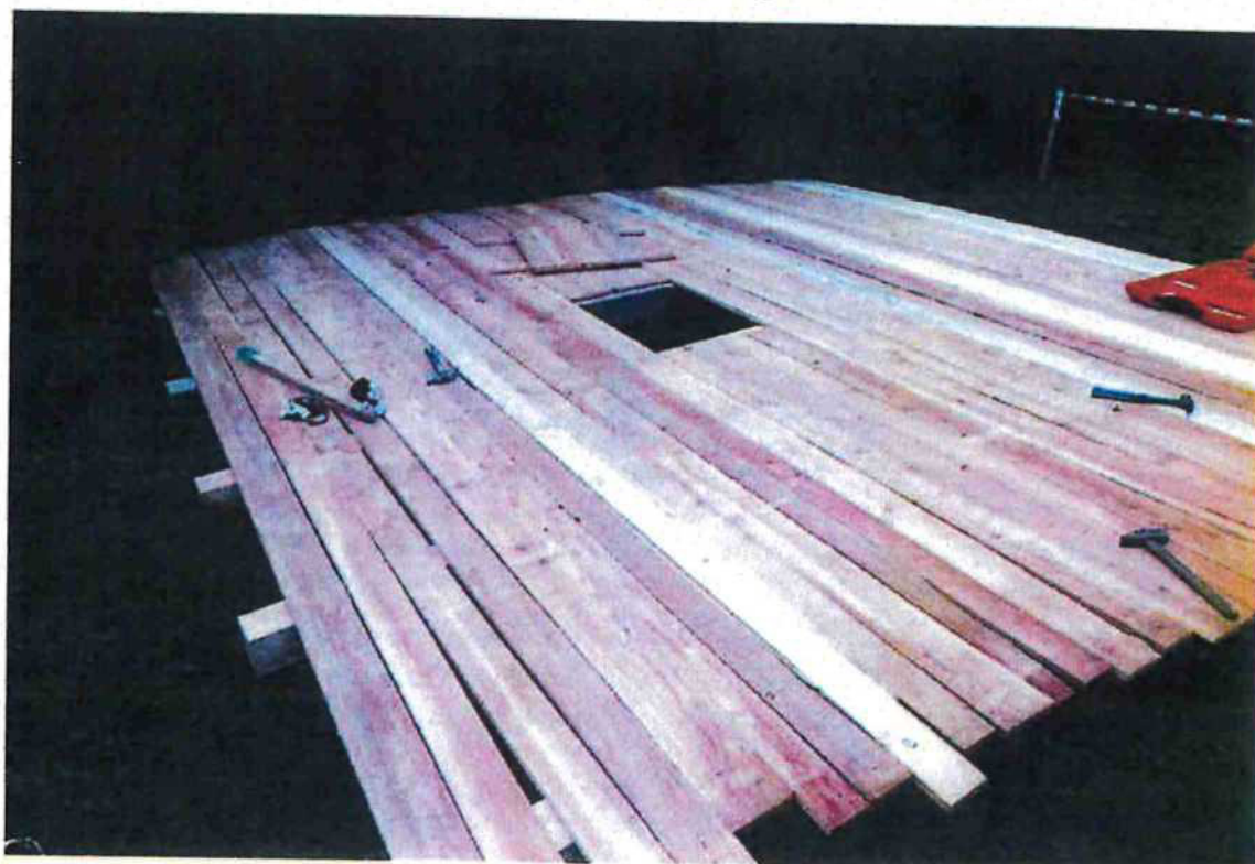
Stavba ochranného povalu
