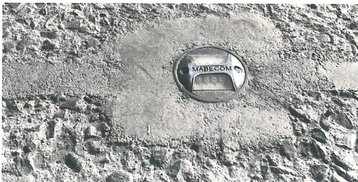
Obrázek 6: Led signalizace nákladu převyšující max. povolenou výšku 4,2m
