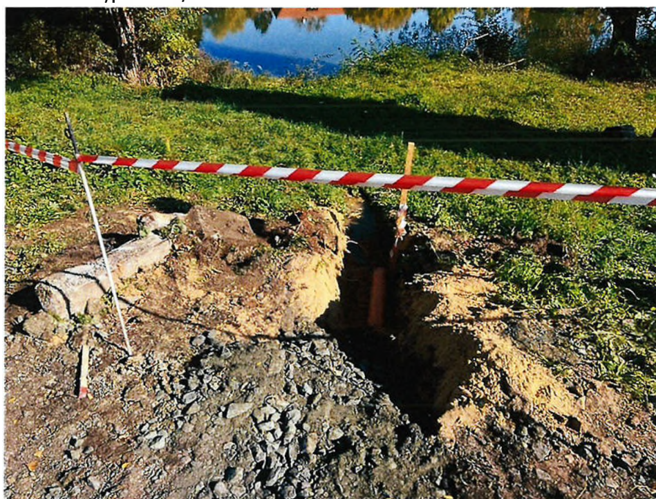
Překop drenáže, vyústění směr do rybníka
