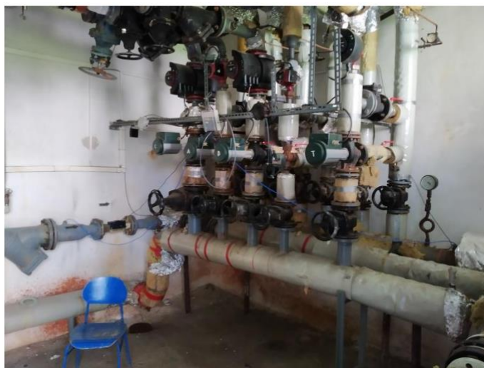
Obrázek 86: Rozdělovač otopné vody
