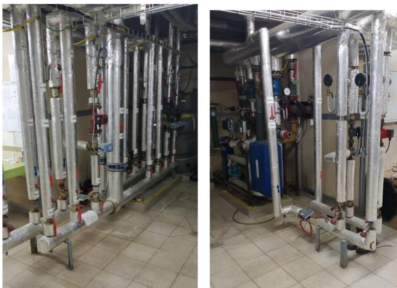
Obrázek 197: KD Radost – topné okruhy, výměník tepla
