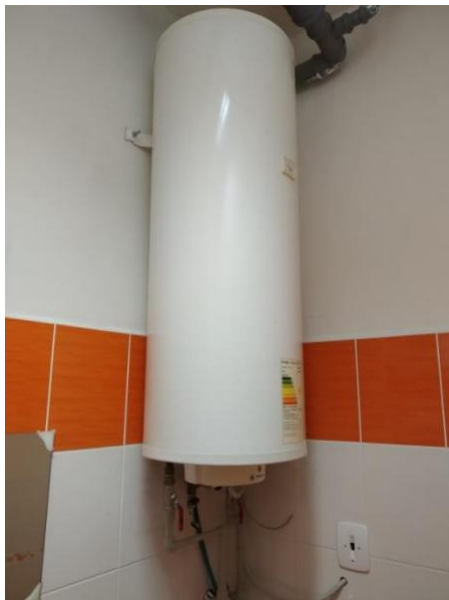
Obrázek 128: Elektrický boiler Tatramat typ EOV 152, objem 150 litrů, příkon 2 kW
