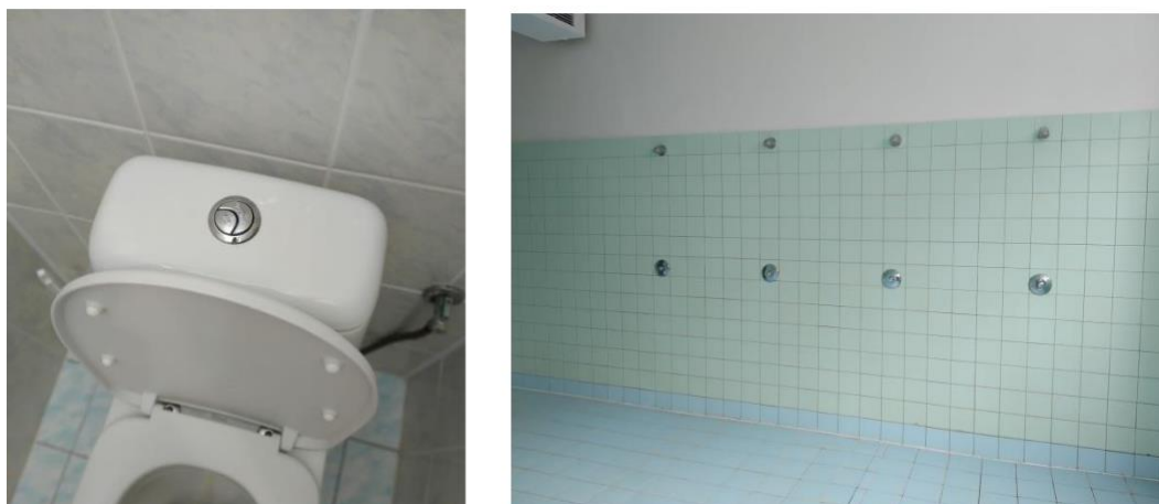
Obrázek 81: Dvojité splachování – toalety (vlevo) a úsporné výtokové hlavice se stop ventily – sprchy (vpravo)
