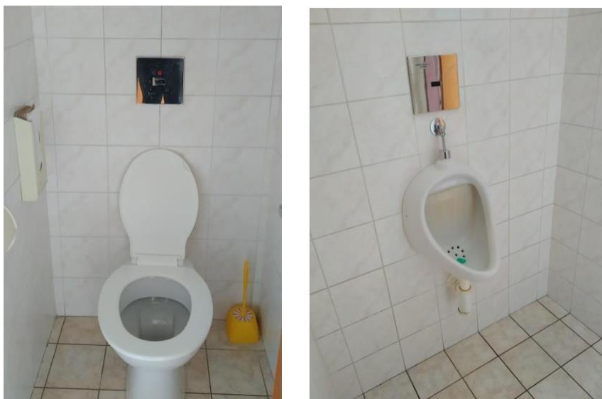
Obrázek 219: Senzorové splachování toalety (vlevo) a senzorové splachování pisoáry (vpravo)
