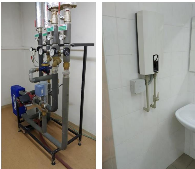
Obrázek 186: Ohřev TV v šatnách velkého sálu – KD Petra Bezruče (vlevo – výměník tepla, vpravo – průtokový ohřev)
