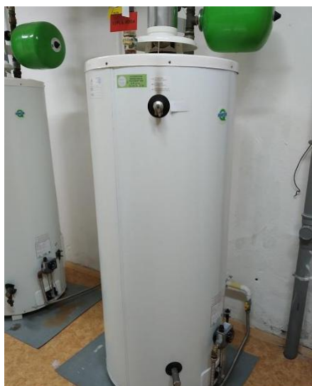
Obrázek 62: Plynový ohřev TV pro kuchyň ZŠ 1. Máje (suterén kuchyně)
