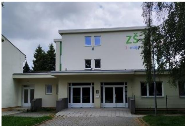
Obrázek 57: Hlavní budova ZŠ 1. Máje, hlavní vstup
