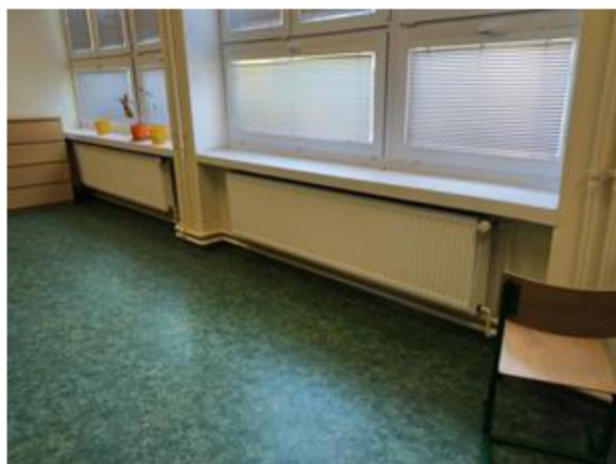
Obrázek 101: Desková otopná tělesa – pavilon B třídy (vlevo) a litinová článková otopná tělesa - chodby (vpravo)
