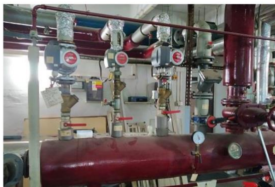
Výměníková stanice ZŠ Gorkého (vlevo výměníky, vpravo hlavní rozvaděč topné vody)
