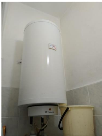
Obrázek 77: Elektrický boiler Tatramat
