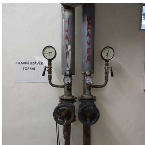
Obrázek 63: Hlavní uzávěr otopné vody pro kuchyň ZŠ 1. Máje (suterén kuchyně)
