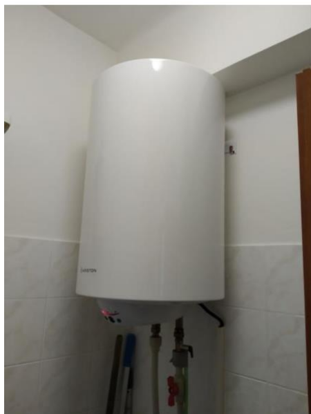
Obrázek 214: Zásobník teplé vody Ariston o objemu 75 litrů a příkonu 2,0 kW (část A)
