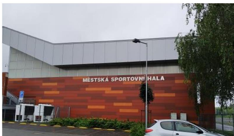
Obrázek 171: Budova sportovní haly Slavie (severozápadní pohled)
