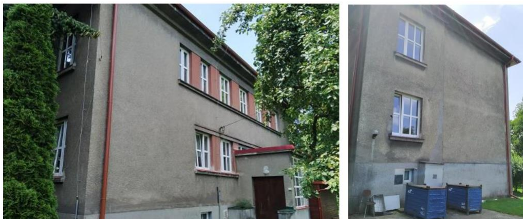
Obrázek 51: Hlavní budova ZŠ Havířov-Životice (vlevo - východní fasáda, vpravo – severní fasáda)
