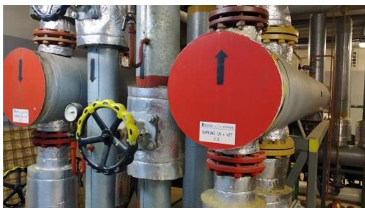
Obrázek 164: Domov seniorů LUNA – ležaté výměníky tepla pro vytápění a ohřev vzduchu ve VZT
