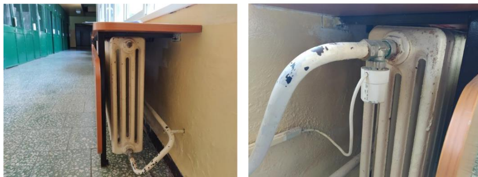
Obrázek 88: Litinová článková otopná tělesa (vlevo) a IRC regulace (vpravo)
