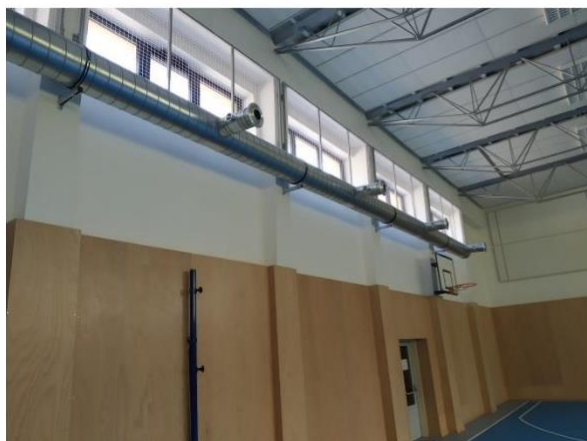
Obrázek 103: Vzduchotechnické zařízení – kuchyně (vlevo) a tělocvičny (vpravo)
