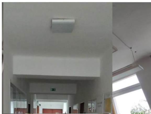
Obrázek 216: LED osvětlovací tělesa v části C 1. NP kanceláře (vlevo) a na chodbách (vpravo)
