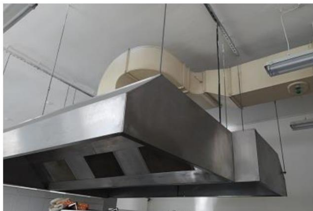
Obrázek 33: Digestoř pro prostory vaření ZŠ Kpt. Jasioka
