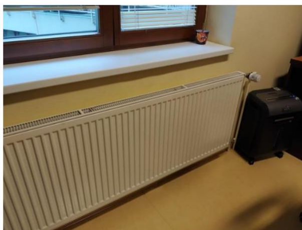
Obrázek 243: Panelová desková otopná tělesa s TRV
