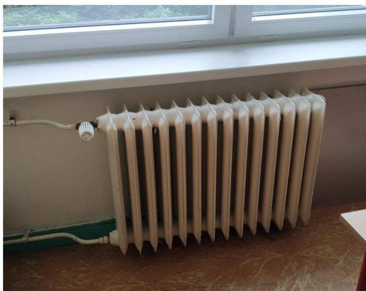
Obrázek 139: Litinová článková otopná tělesa s TRV
