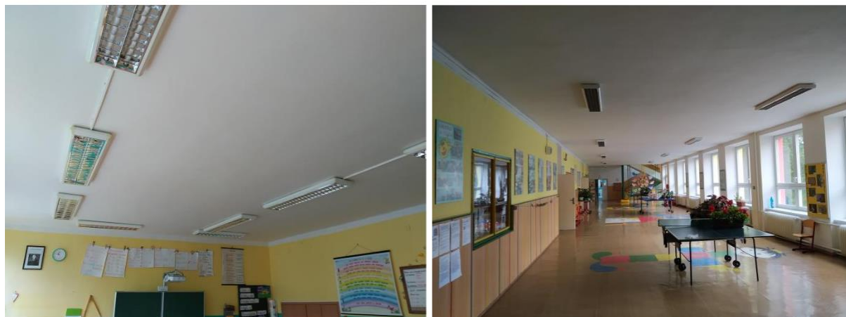
Obrázek 143: Zářivková svítidla učebny (vlevo) a chodby (vpravo)
