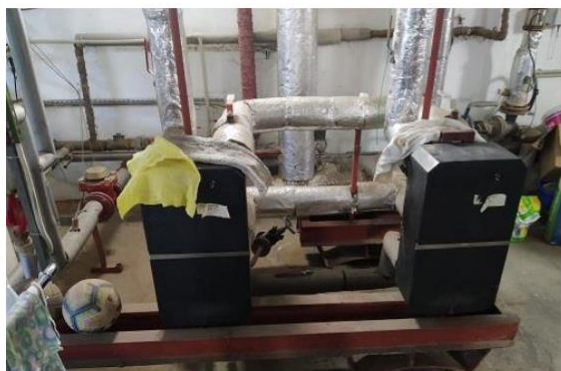
Výměníková stanice ZŠ Gorkého (vlevo výměníky, vpravo hlavní rozvaděč topné vody)
