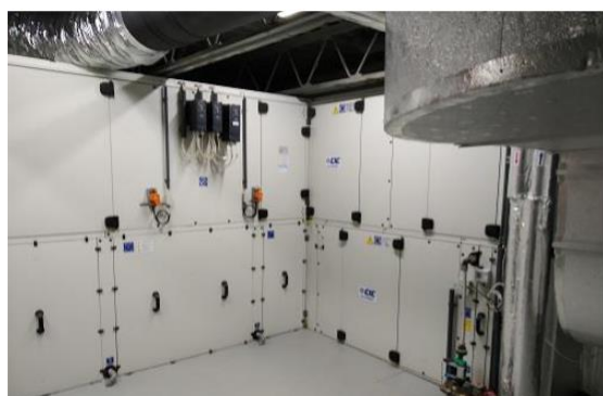
Obrázek 178: VZT zařízení sportovní hala Slavie (odvlhčovací zařízení vlevo, distribuční elementy malá tělocvična vpravo)
