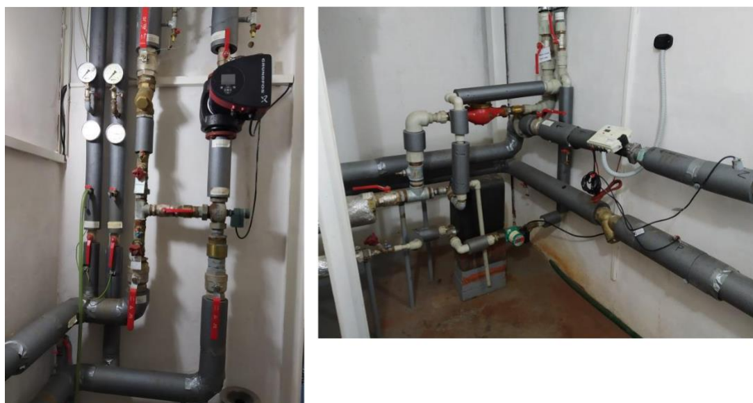
Obrázek 230: Napojovací uzel ÚT
