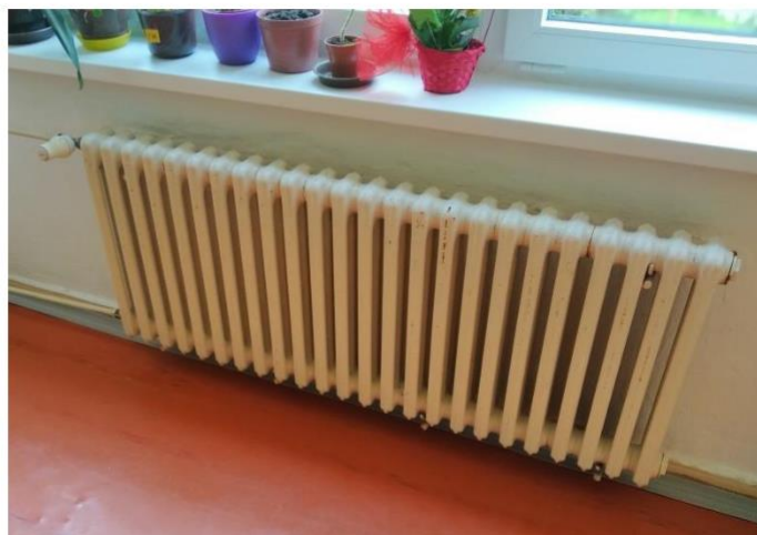
Obrázek 75: Litinová článková otopná tělesa s TRV
