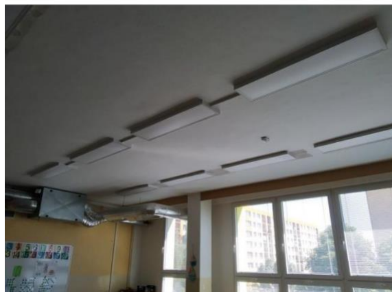
Obrázek 119: Osvětlovací soustava (LED) – třídy
