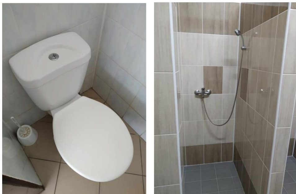
Obrázek 94: Dvojité splachování – toalety a klasické sprchové hlavice (vpravo)
