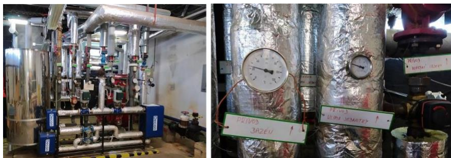
Obrázek 175: Výměníková stanice sportovní hala Slavie (vlevo výměníky + zásobník TV, vpravo regulace vytápění WinTherm)
