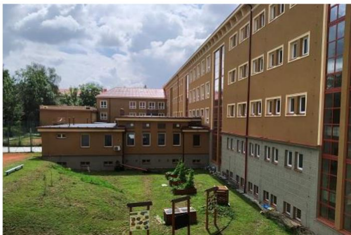
Obrázek 39: Školní kuchyně – jednopodlažní objekt v popředí (severovýchodní pohled), severovýchodní pohled na střední trakt - ZŠ Na Nábřeží
