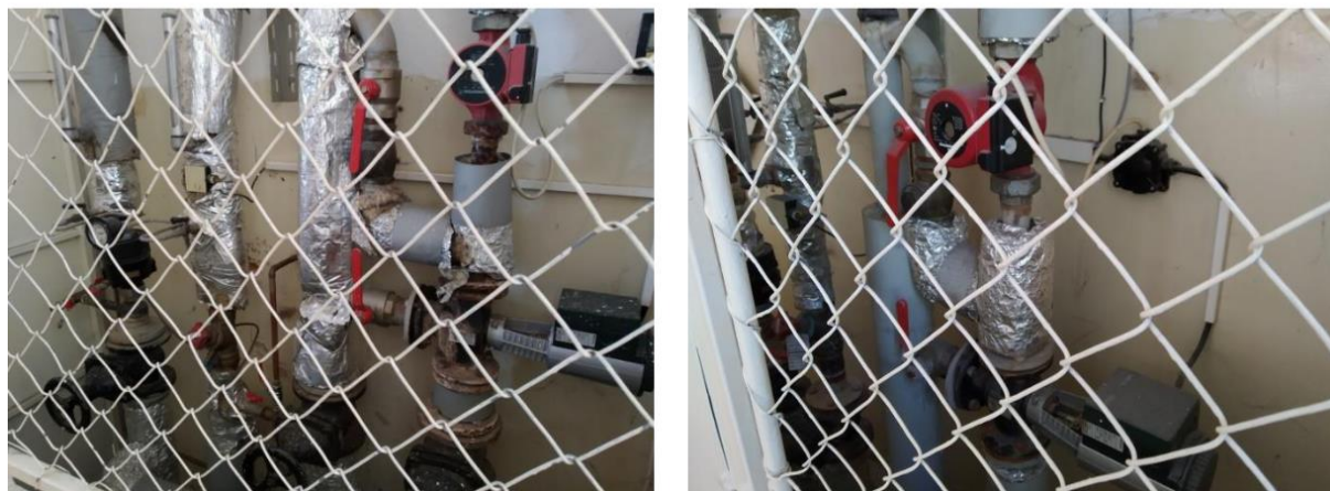
Obrázek 126: Regulační uzly otopné soustavy
