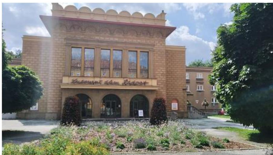
Obrázek 194: Budova KD Radost – hlavní vstup (severovýchodní fasáda)
