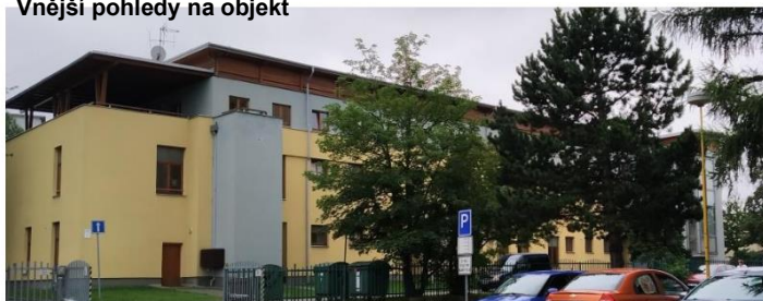
Vnější pohledy na objekt
