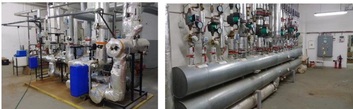
Obrázek 184: KD Petra Bezruče – výměníky tepla (vlevo), kombinovaný rozdělovač/sběrač pro vytápění (vpravo)
