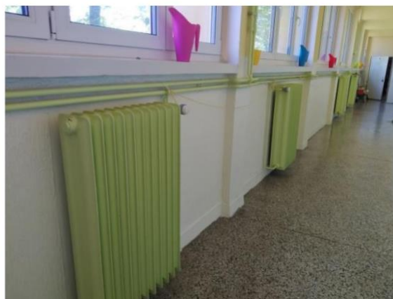
Obrázek 101: Desková otopná tělesa – pavilon B třídy (vlevo) a litinová článková otopná tělesa - chodby (vpravo)
