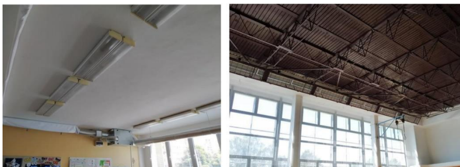
Obrázek 118: Osvětlovací soustava (zářivky) – třídy (vlevo) a tělocvična (vpravo)
