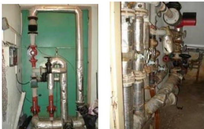
Obrázek 19: Výměňková stanice ZŠ K. Světlé (vlevo centrální regulační uzel, vpravo regulační uzel pro jídelnu a družinu)
