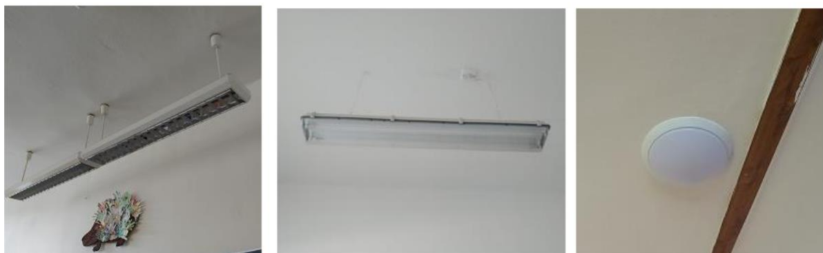
Obrázek 34: Osvětlení ZŠ Kpt. Jasioka (vlevo a uprostřed – zářivkové osvětlení, vpravo – LED zdroje)
