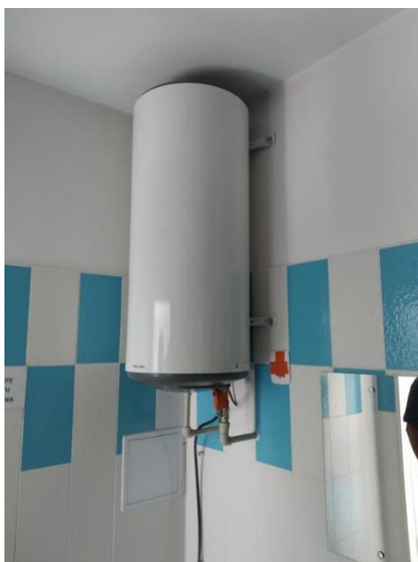
Obrázek 115: Elektrický boiler Stibel Eltron á 2,2 kW
