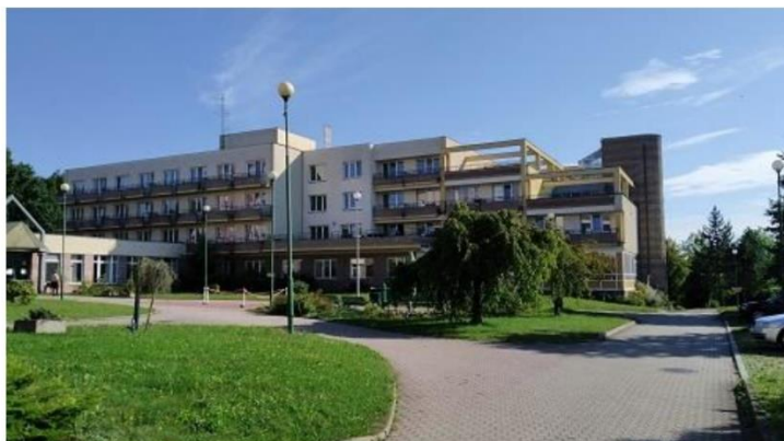
Obrázek 162: Domov seniorů LUNA – hlavní vstup, západní pohled na budovu C
