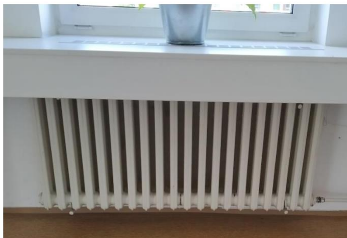
Obrázek 127: Litinová článková otopná tělesa s TRV
