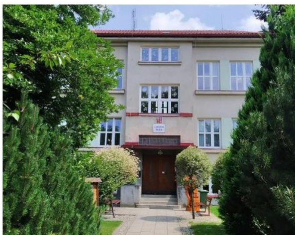
Obrázek 49: Hlavní budova ZŠ Havířov-Životice (západní pohled – hlavní vstup)
