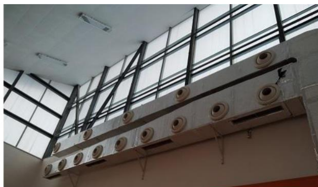
Obrázek 178: VZT zařízení sportovní hala Slavie (odvlhčovací zařízení vlevo, distribuční elementy malá tělocvična vpravo)
