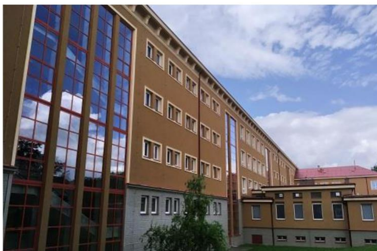
Obrázek 40: Školní budova – severovýchodní pohled na střední trakt – ZŠ Na Nábřeží
