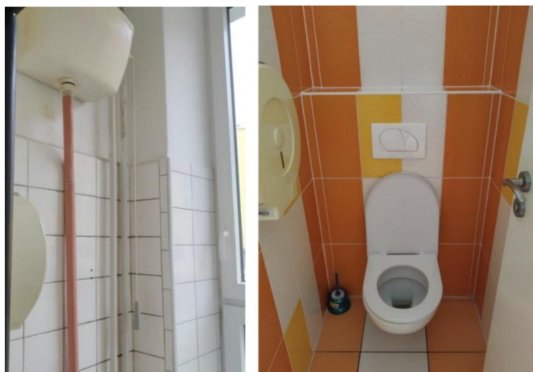
Obrázek 144: Jednoduché splachování – toalety (vlevo) a dvojitě splachování – část A (vpravo)
