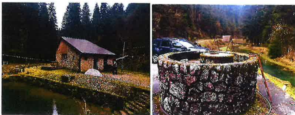
Obr. 7 Celkový pohled na stávající zdroj surové vody Bioštica
