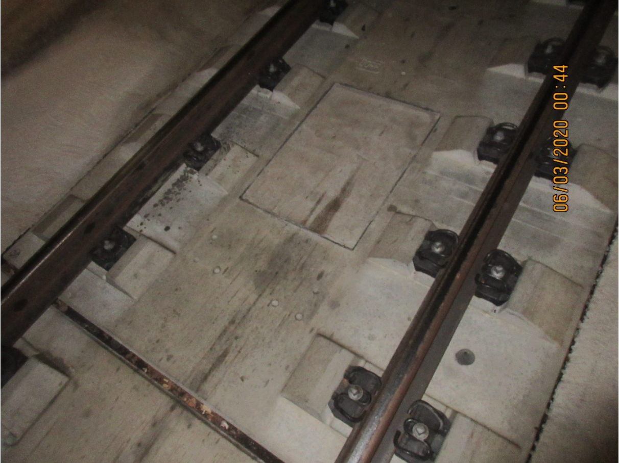
nečistoty mezi panely pevné jízdní dráhy
