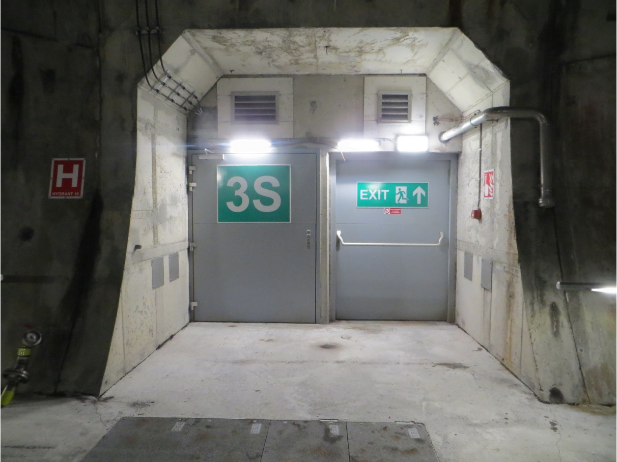
dveře do tunelové propojky z tubusu tunelu
