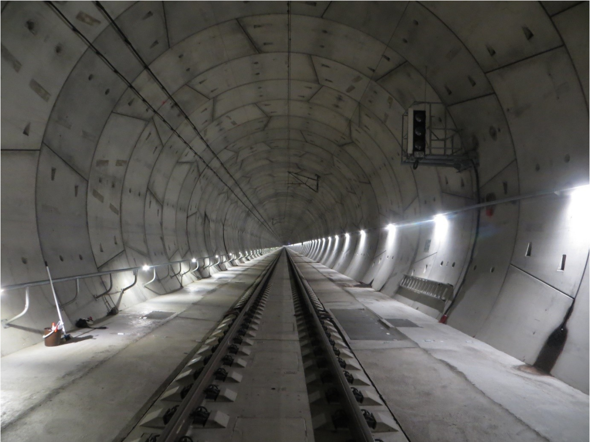
pohled do tubusu tunelu
