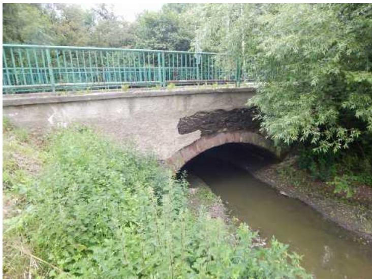
Pohled na pravý bok mostu.
