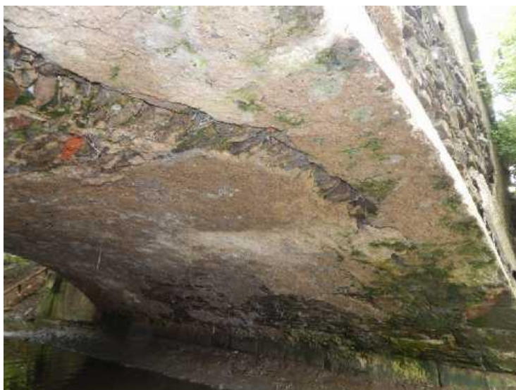
Spodní líc nosné konstrukce.
