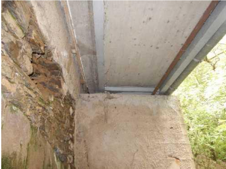
Spodní líc nosné konstrukce lávky.
