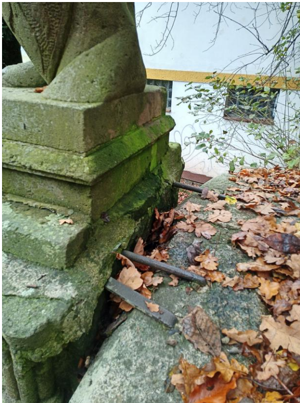
Foto 7, 8 Způsob kotvení ocelových kramlí do betonových výplní v zadní části římsy, defekty a praskliny v dekorativních částech.
