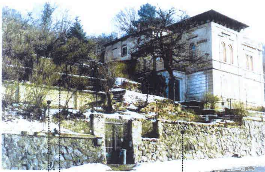
TERASY ..... OVOCNÁ ZAHRADA ..... OPĚRNÉ STĚNY
