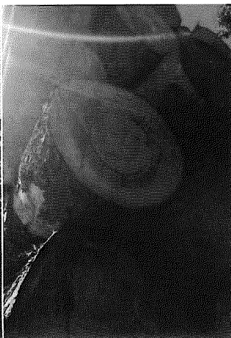
Odlupčivá trhlina – dovoľuje sa
