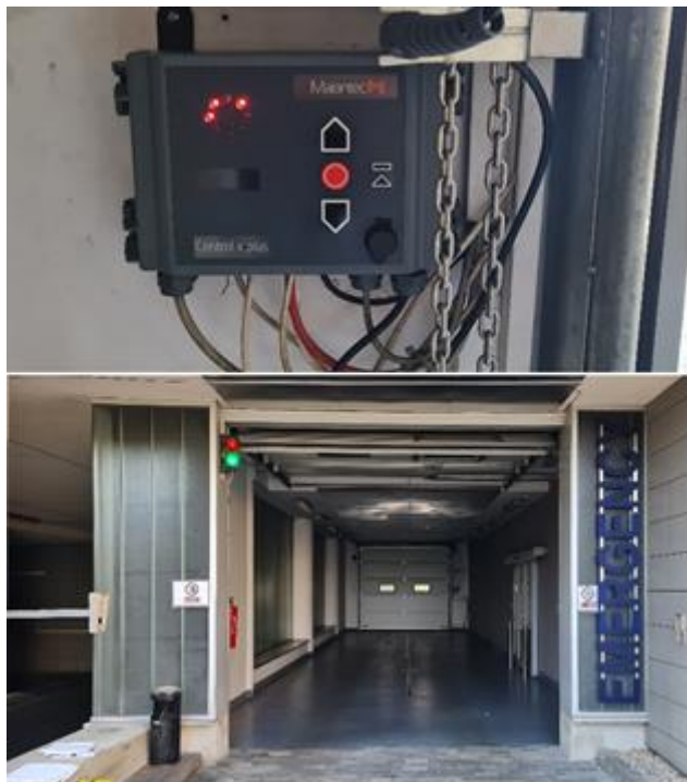
Obr. č.2 Vjezd EMR vč. ovládacího prvku s označením MarantecM Control x.plus
