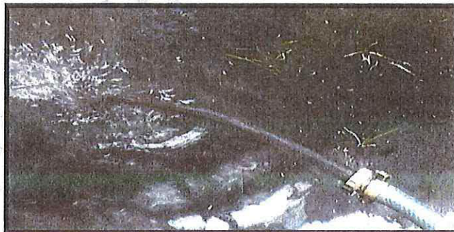
Vypuštění rozpuštěného nánosů z ÚT:
