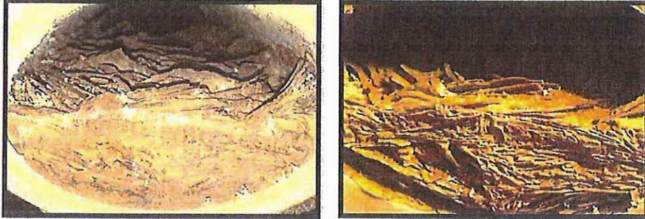
Rozvod teplé vody - Potrubí před čištěním:
