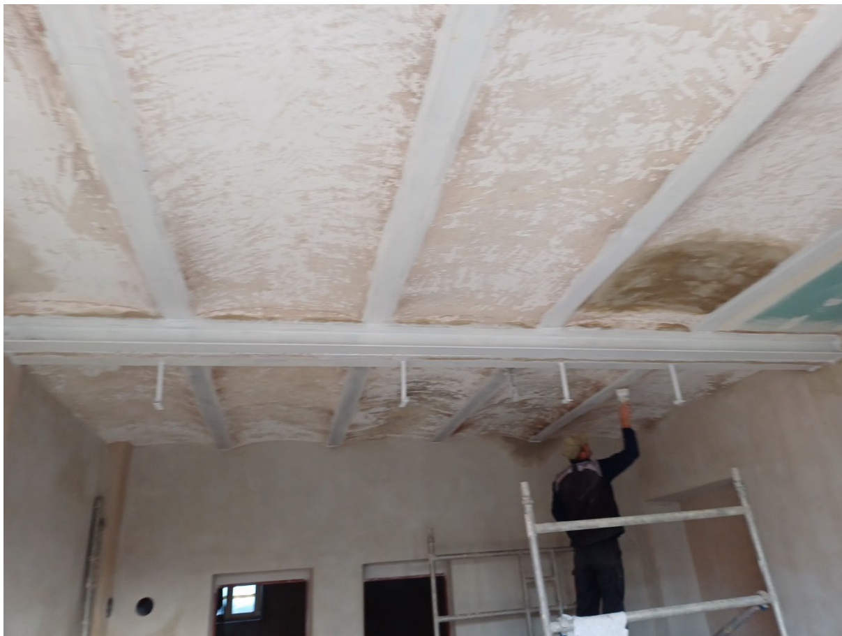
Z1 – oprava omítek, Z7 – očištění a nátěr OK
