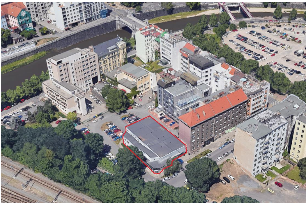
Obr. 2: Pohled na předmětné území z jihovýchodu
