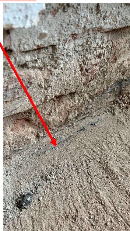
Obrázek č. 2 – Odhalené zdivo a základová deska
