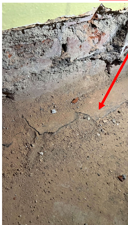
Obrázek č. 1 – Odhalené zdivo a základová deska
