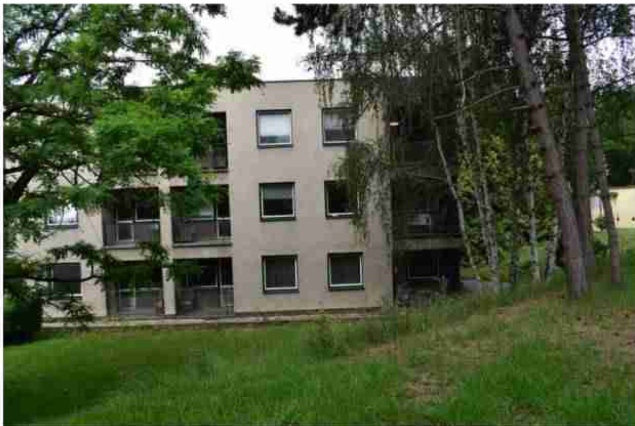
Pavilon B – východní pohled, severní křídlo
