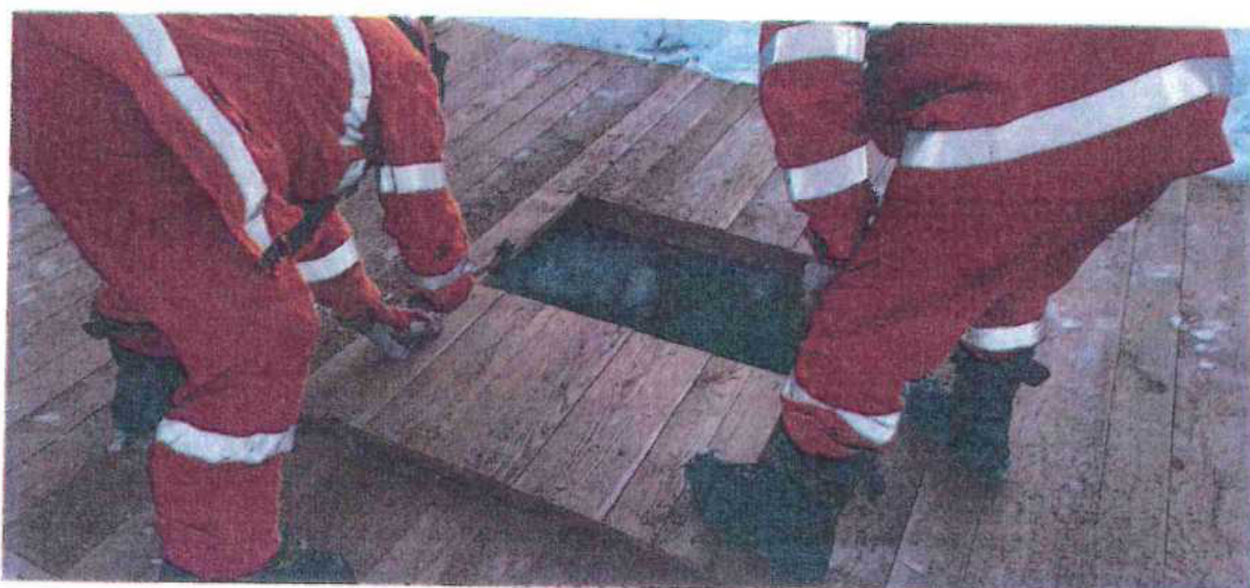
Zhotovení kontrolního otvoru
