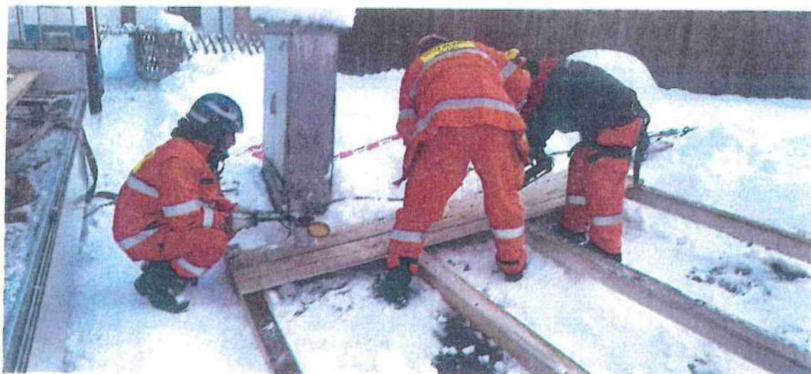
Stavba ochranného povalu
