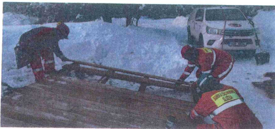
Stavba ochranného povalu
