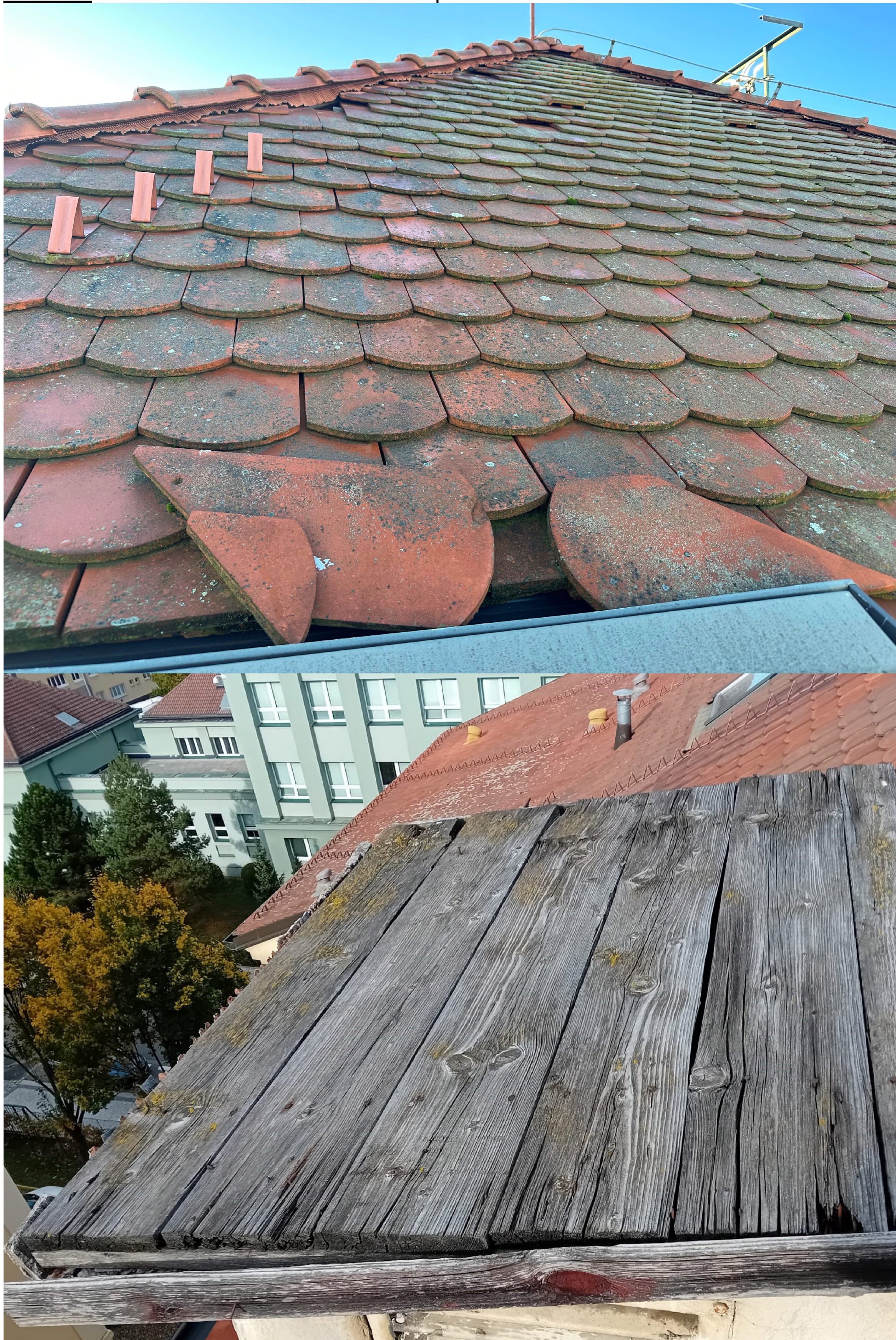
Příloha: Foto aktuálního stavu střešního pláště
