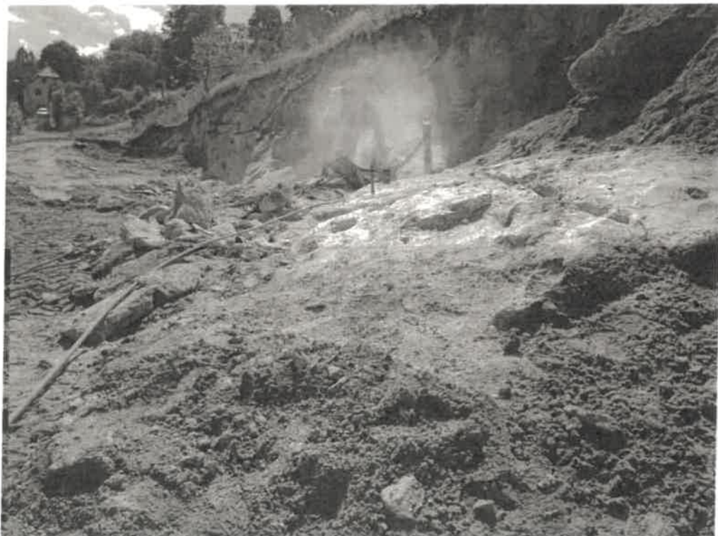
SO 602, ruční navrtávání horniny a následné dolamování
