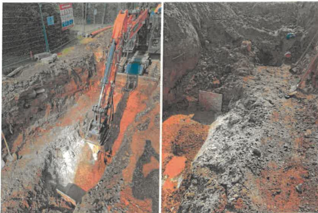
SO 313, rozpojování horniny sbíjecím kladivem, rozpojená hornina
