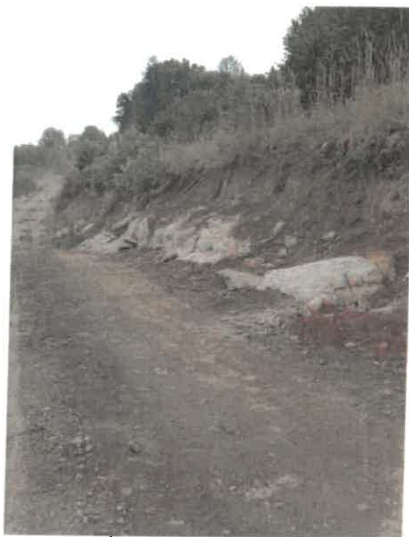
Úsek cca km 7,230-7,240 výchozy / bloky skalní horniny v místě těžby
