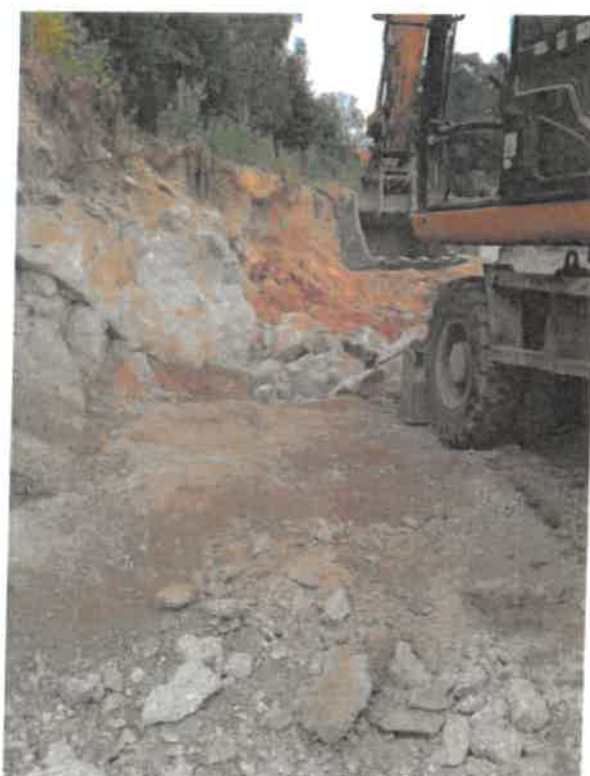
km 7,150 – nakládání rozpojené horniny
