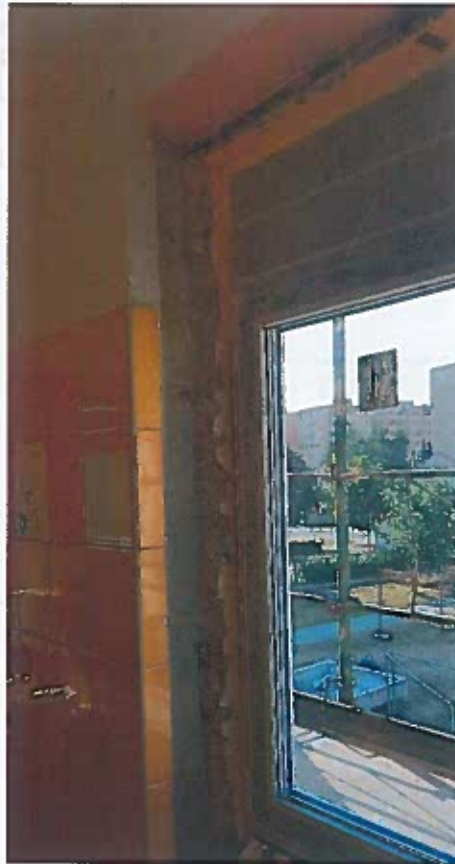
Ozub vnějšího panelu kolem okna před vyrovnáním (III.etapa).
