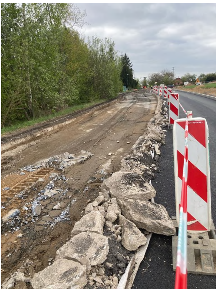
Podklad. bet. konstrukce km 1,450-1,600
