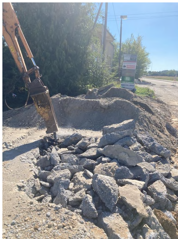
Bourání betonových podkladů v km 1,450
