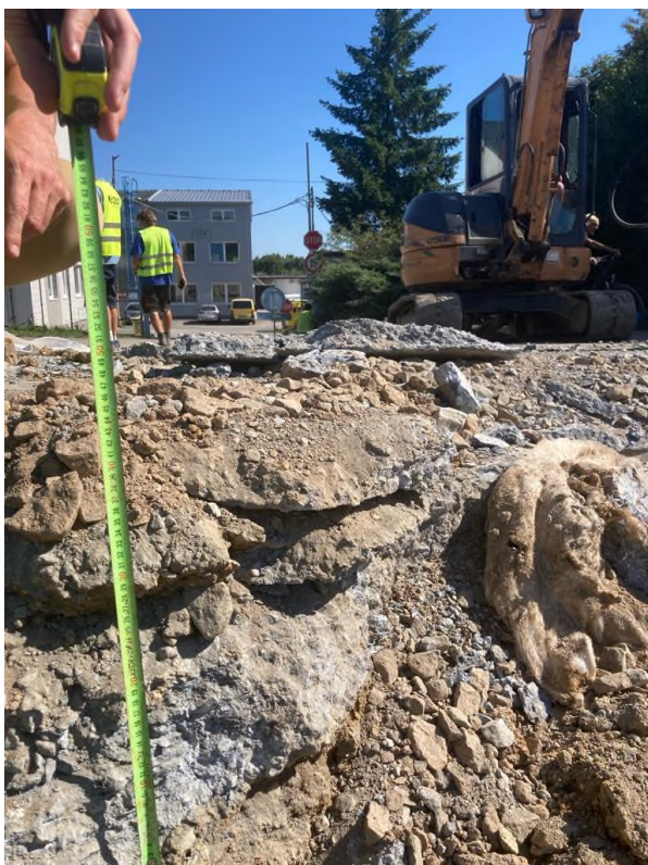
Bourání betonových podkladů v km 1,450
