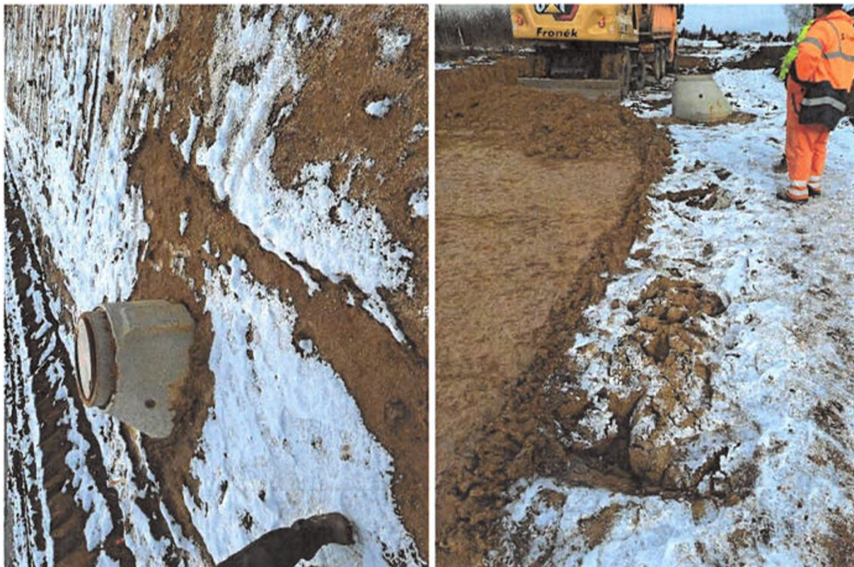
foto 1-2 / AZ zásyp SO 301.2 – Dešťová kanalizace, Větev C v hl. trase – km 0,9
