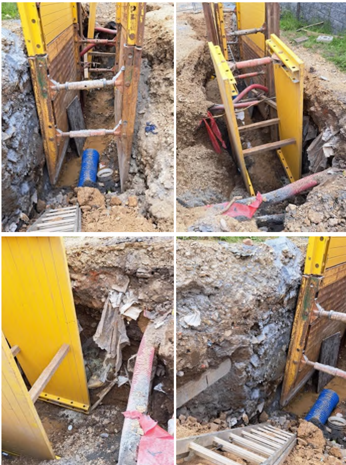
foto 7-10/ výkop SO 03 – Splašková kanalizace
