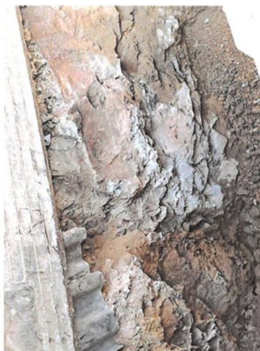
foto 3-4/ výkop SO 02 – Dešťová kanalizace
