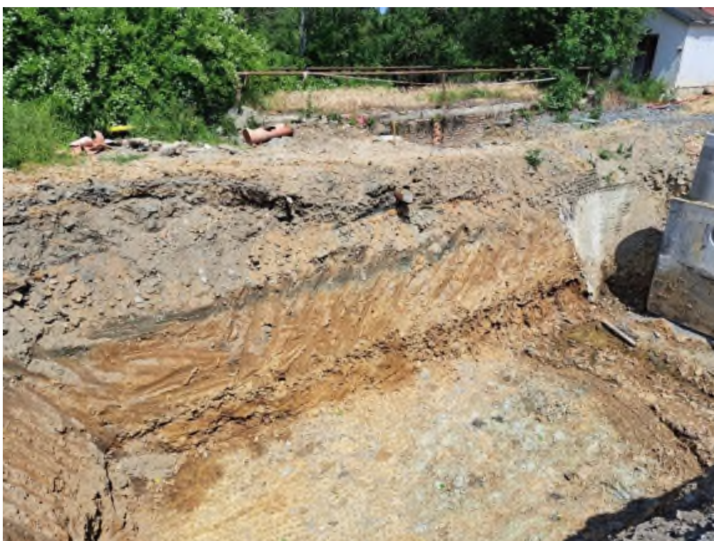
foto 1-2 / výkop SO 301.1 – základová spára SO 361 RN1
