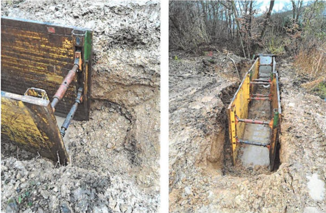
foto 5-6/ odvodnění RN1 (SO 361) k SO 321
