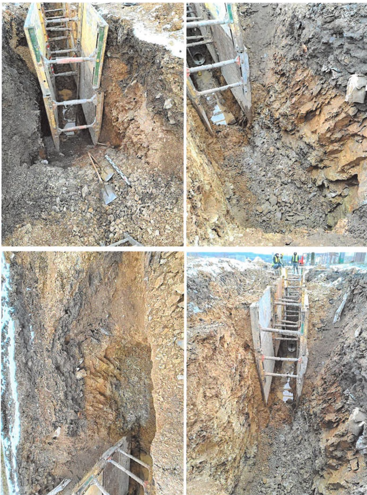
foto 9-12 / výkop SO 02 – Dešťová kanalizace
