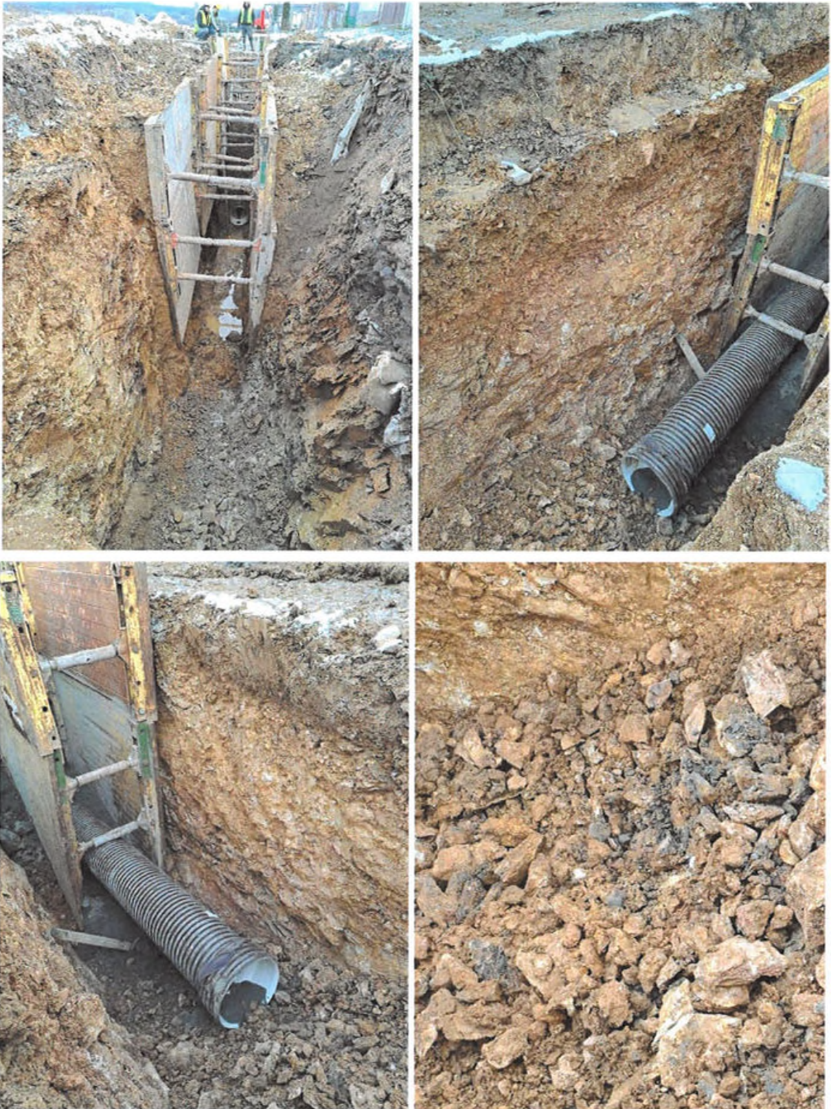
foto 5-8 / výkop SO 301.2 – Dešťová kanalizace, Větev C v hl. trase – km 1,25
