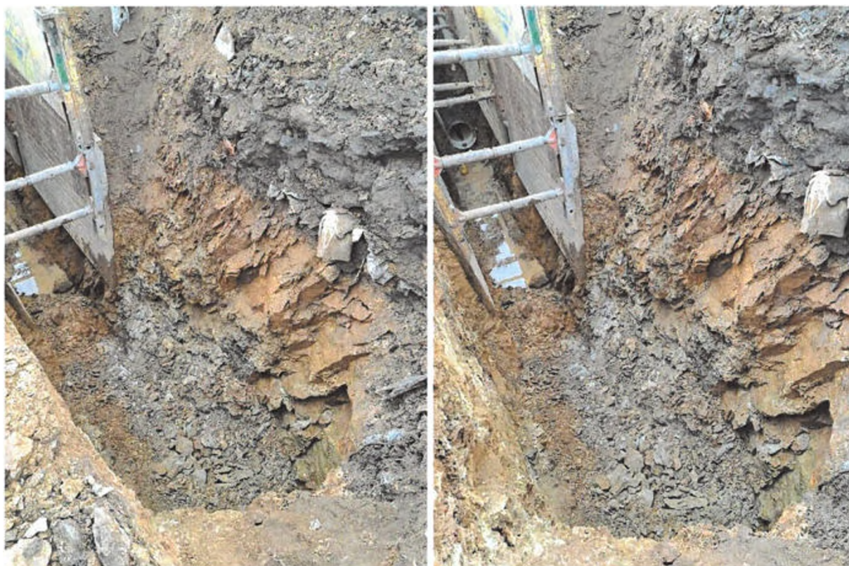
foto 3-4 / výkop SO 301.2 – Dešťová kanalizace, Větev C v hl. trase – km 1,25
