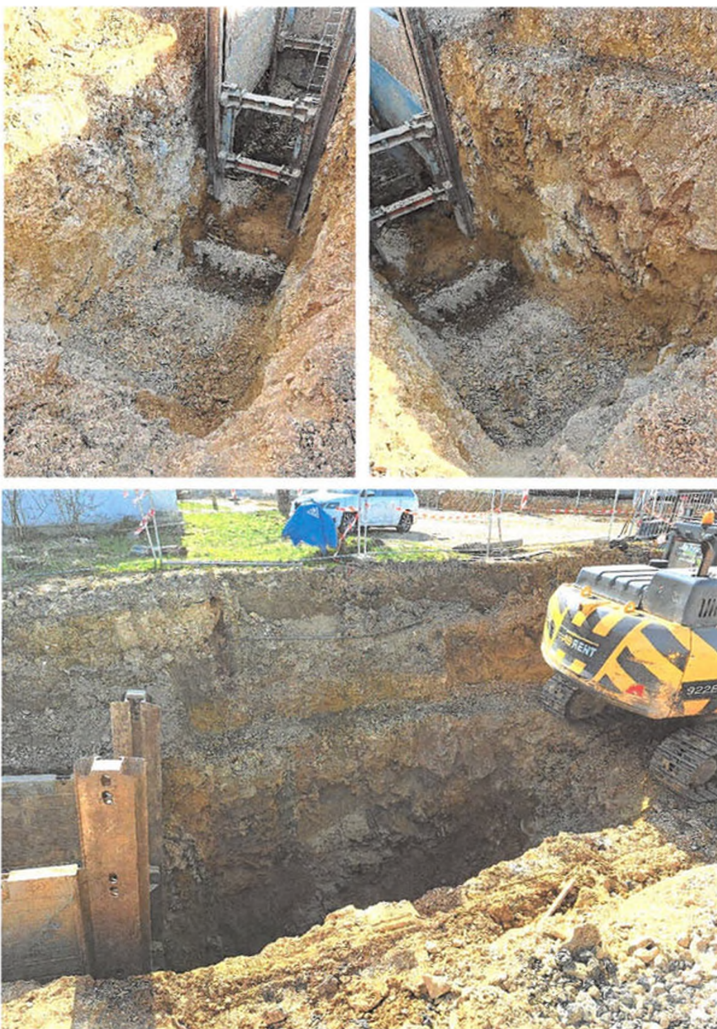
foto 1-3 / výkop SO 02 – Dešťová kanalizace
