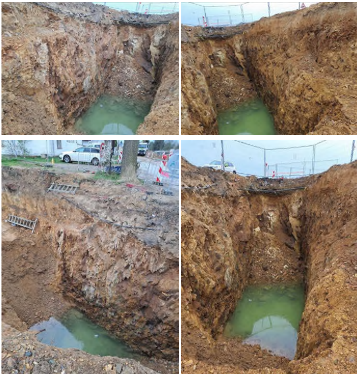
foto 1-4 / výkop SO 02 – Dešťová kanalizace
