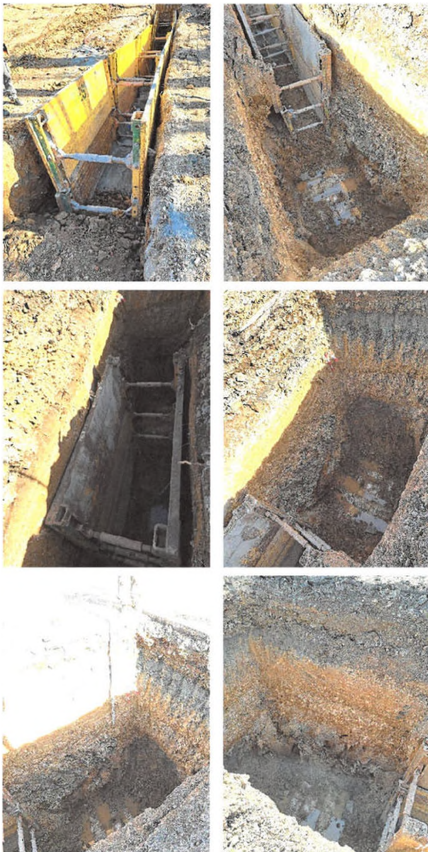
foto 4-9/ odvodnění RN1 (SO 361) k SO 321 – šachta 2 - 3
