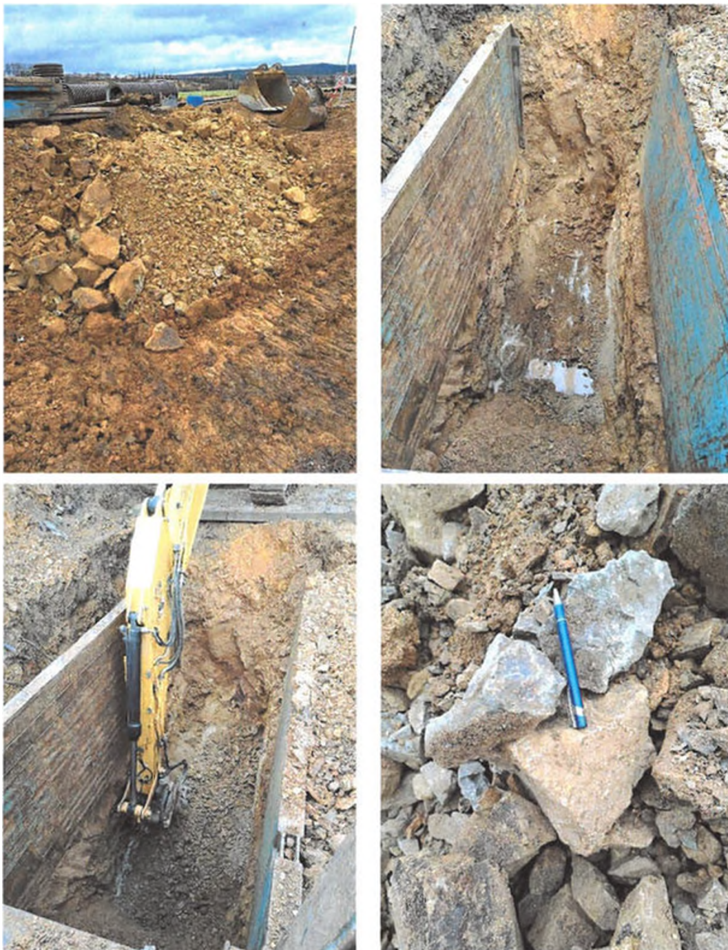
foto 1-4/ výkop SO 02 – Dešťová kanalizace
