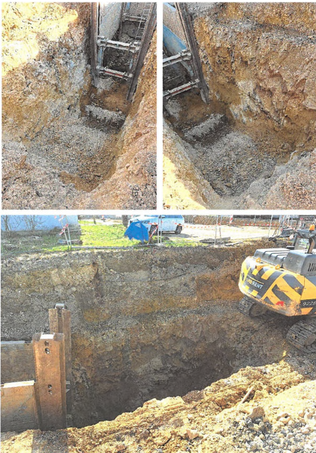
foto 1-3 / výkop SO 02 – Dešťová kanalizace
