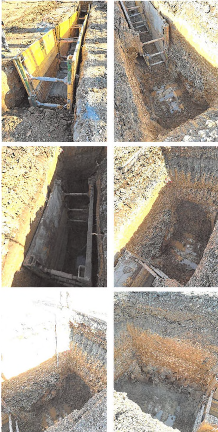
foto 4-9/ odvodnění RN1 (SO 361) k SO 321 – šachta 2 - 3
