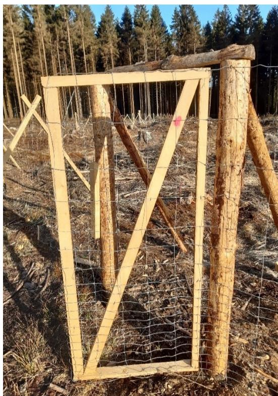
Pletivo přibité na dřevěný rám (lať, přířezy, krajinky). Zajištění proti samovolnému otevření z venkovní strany pomocí dřevěného kolíku umístěném ve středu kůlu (sloupu) prostřednictvím hřebíku (vrutu). Samovolné otevření do prostoru oplocenky je zajištěno zarážkou (kolíkem) o průměru min. 7 cm a délce min. 50 cm, jež je zatlučen v rostlé zemi min. 40 cm.
