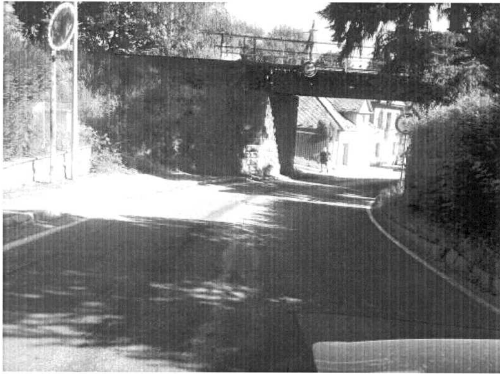
Etapa 2 Sázava – konec úseku
