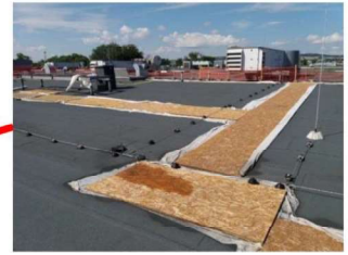
Manipulační chodník na střeše z OSB desek položených na geotextilií.
