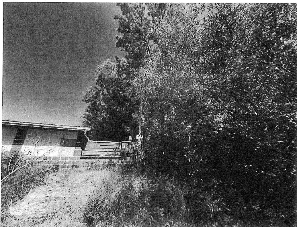
Foto č. 2: Pohled na břehový porost v těsné blízkosti RD a el. vedení na l.b.
