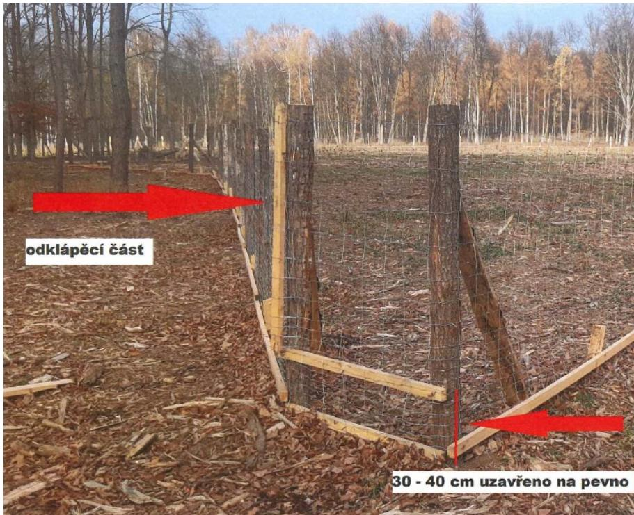
Konec pletiva bude přibitý na lati (kuláček, půlkuláček), jež poslouží k otevírání branky. Odklápací část bude zajištěna proti samovolnému otevření pomocí dvou zahnutých hřebíků umístěných ve spodní a horní části nosného kůlu. Spodní část branky 30-40 cm od země uzavřena na pevno – 2x lat (ráhno).
