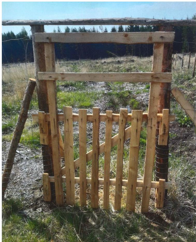
Dřevěná branka z latí (ráhen) výšky 160 cm. Podélně umístění prvků (vztaženo k zemi) ve výšce cca 30, 100, 130 a 160 cm. Svislé prvky maximální mezera 5 cm. Zpevnění příčnou latí (ráhnem) mezi cca 30 a 100 cm od země. Uchycení pomocí čtyř zahnutých hřebíků případně dřevěných zámek (viz obr. výše) přichycených hřebíky (případně vruty – ocelové sloupky).
