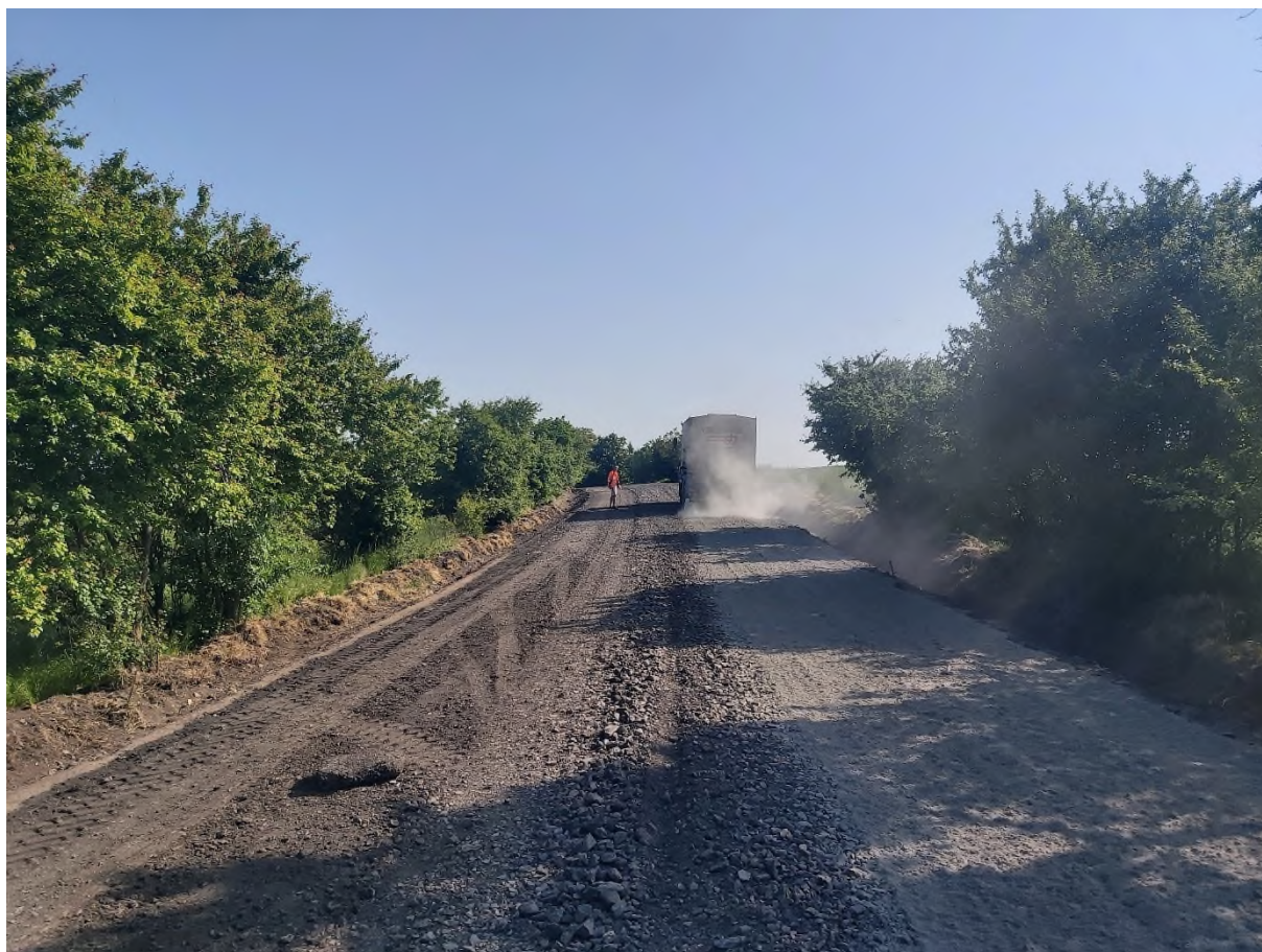
SO 101 - Dávkování pojiva (cementu) na profrézovaný a nahrubo srovnaný povrch. Staničení km 1,560
