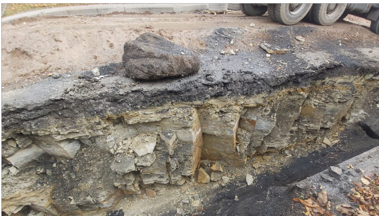
Obr. 5 Skalní masív navětralých slínovců s těžitelností 5. třídy (ČSN 73 3055) vychází místy prakticky až k povrchu terénu (1,850 km).
