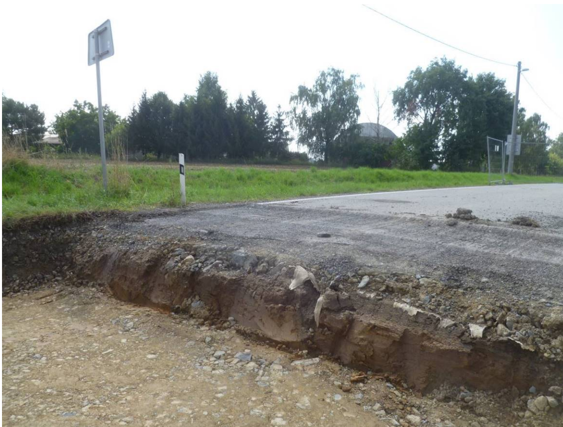
Odfrézovaná a vybouraná vozovka na začátku úseku
