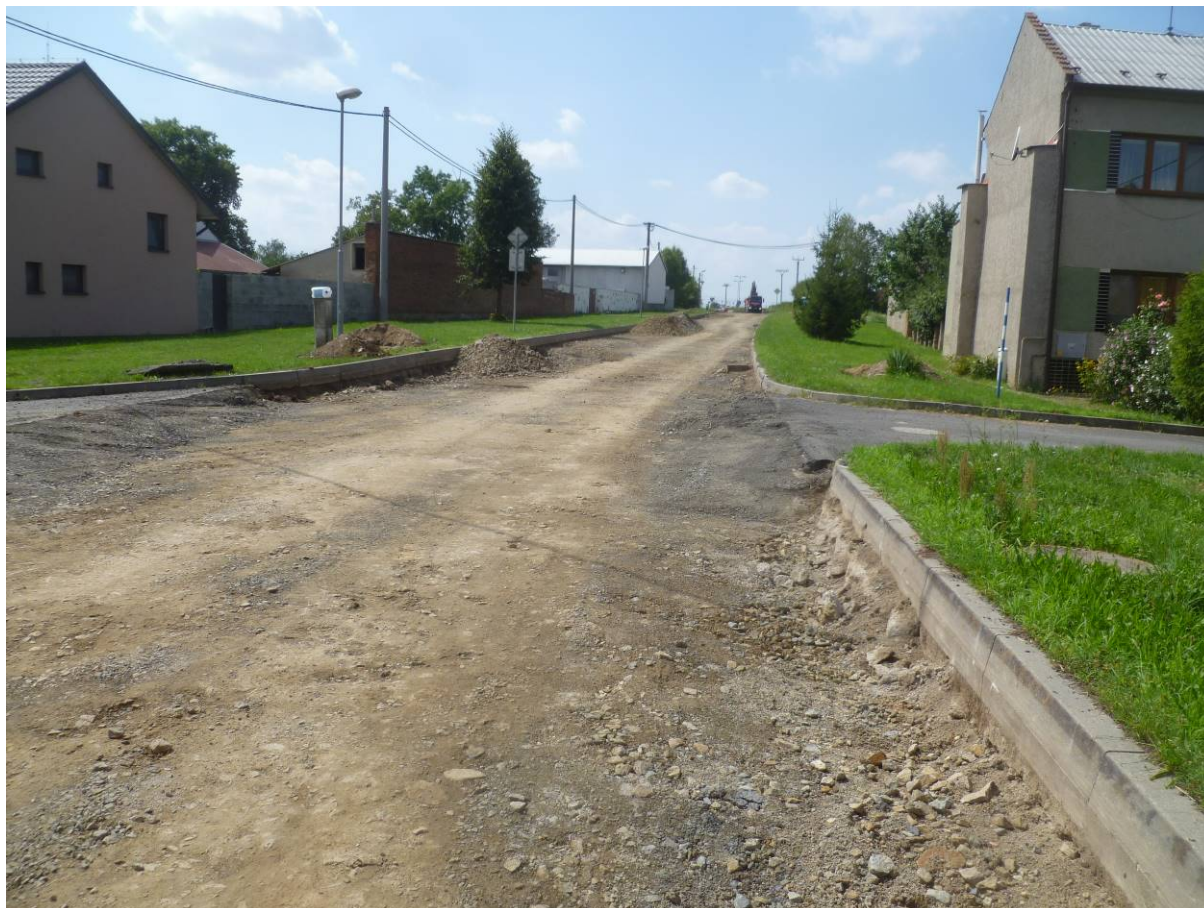
Pohled na vyfrézovanou vozovku v intravilánu i s rozšířením u místních komunikací
