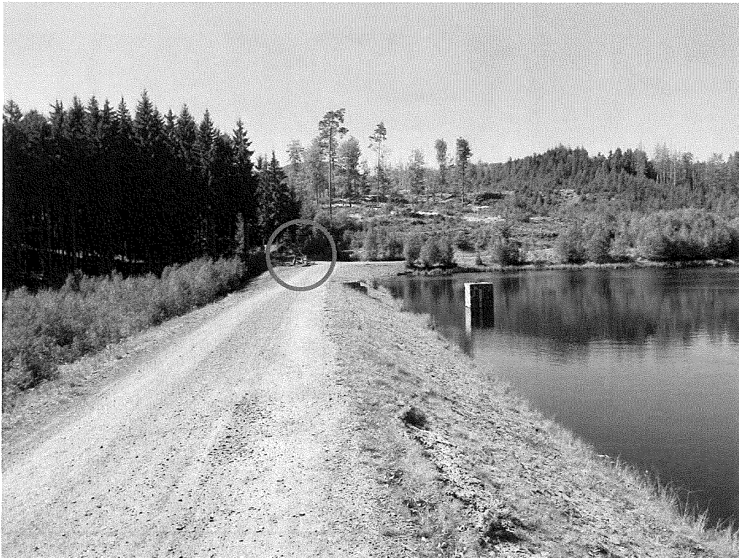
Demontovaná lávka uložená na hrázi
