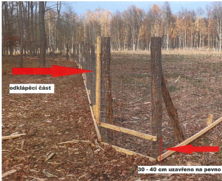
Konec pletiva bude přibitý na lati (kuláček, půlkuláček), jež poslouží k otevírání branky. Odklápací část bude zajištěna proti samovolnému otevření pomocí dvou zahnutých hřebíků umístěných ve spodní a horní části nosného kůlu. Spodní část branky 30-40 cm od země uzavřena na pevno – 2x lať (ráhno).
