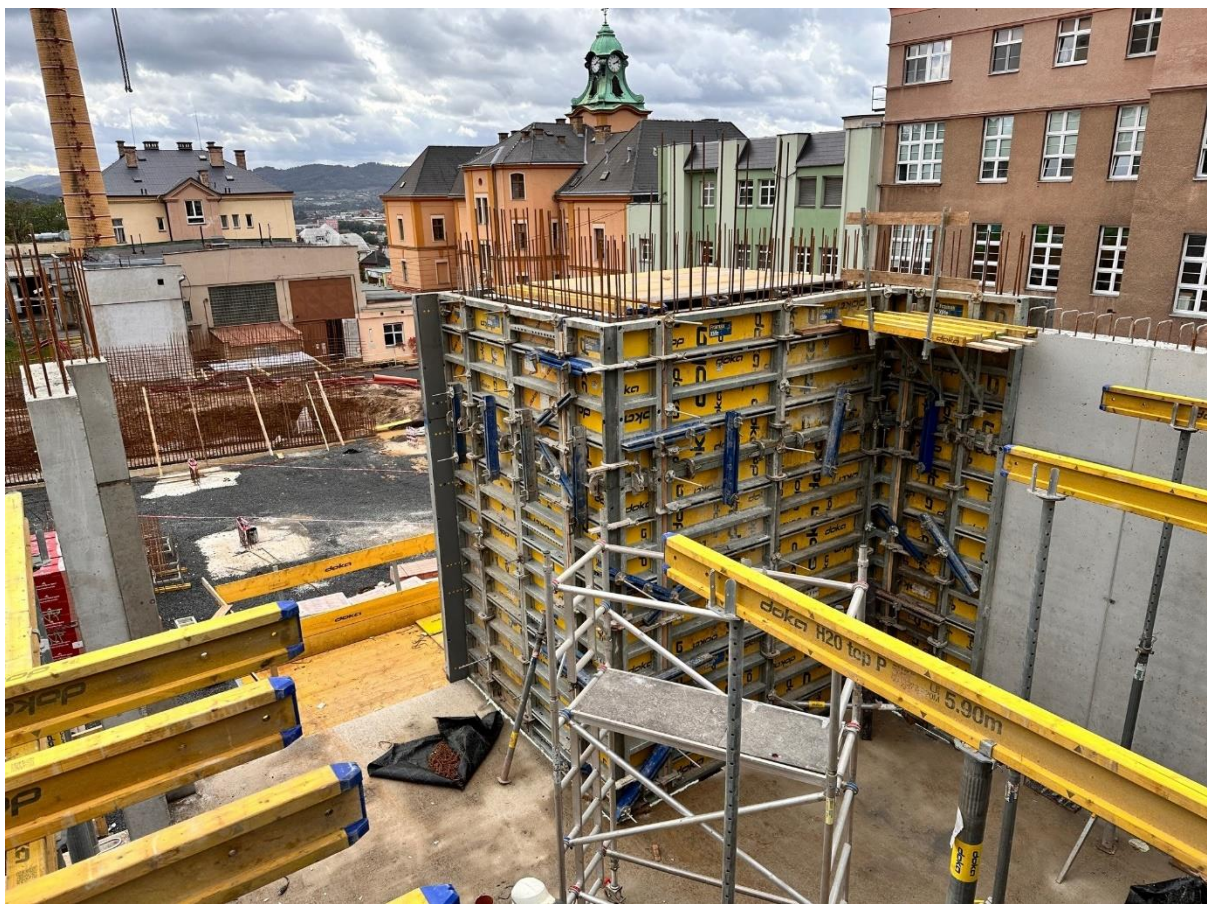
Fotografie z probíhající stavby:
